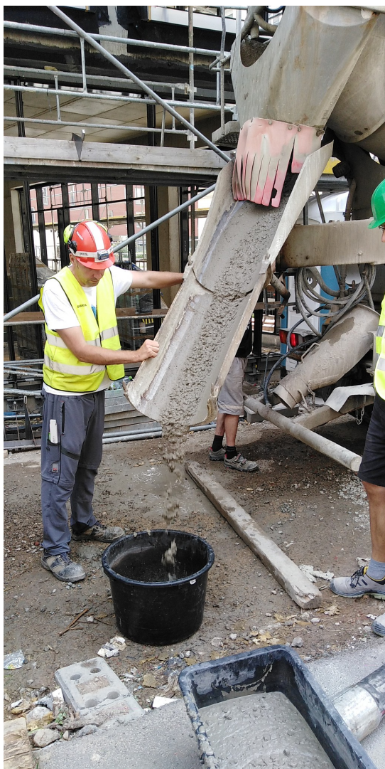
Obr. 10: Odběr betonu na stavbě.
