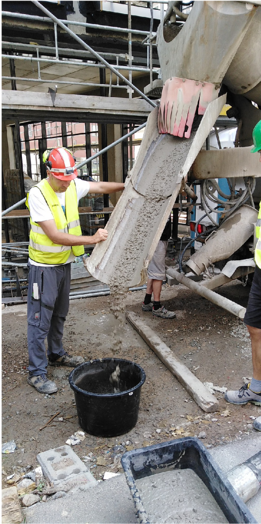
Obr. 10: Odběr betonu na stavbě.
