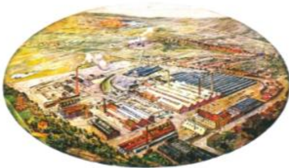
Obr. č. 31: Mannesmannovy závody, [1898]
