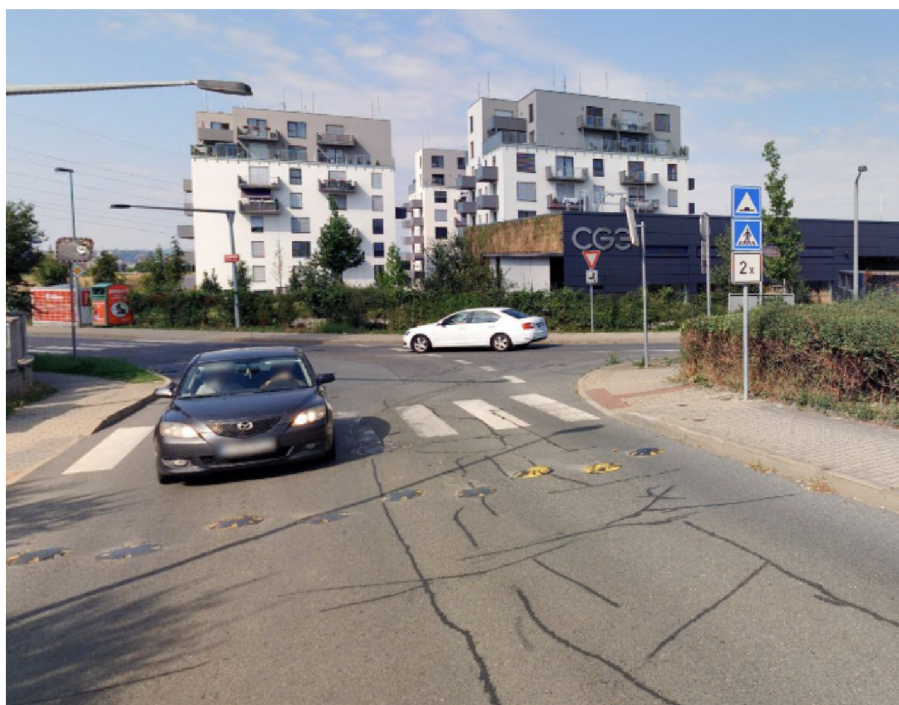
Obrázek 7 Pohled z ulice "Jordánská"
