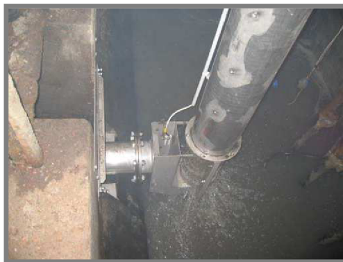
Obr. 5.2 Česle konstantního průměru [13]
