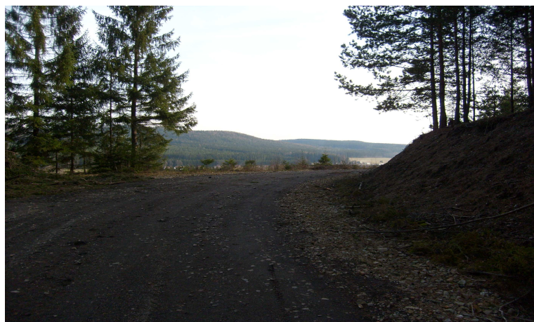
Obr.č.26 – ukázka technického stavu cest
