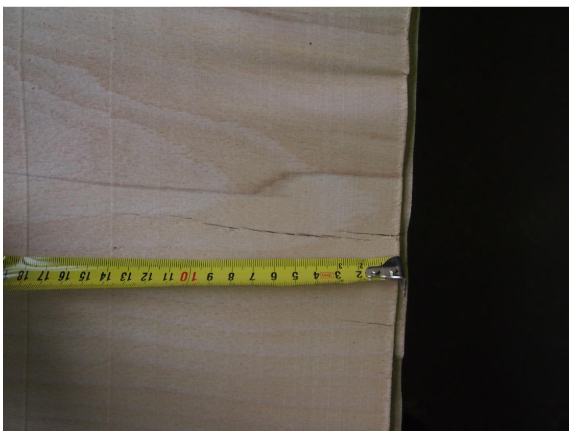
Obr. 17.; Trhlina o délce cca 14 cm (středová část kmene)
