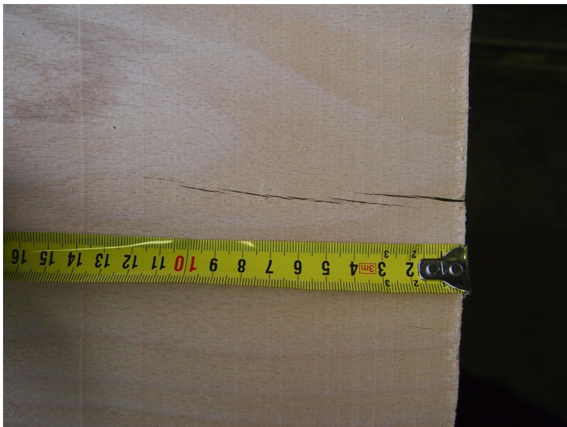
Obr. 18.; Trhlina o délce 11.5 cm
