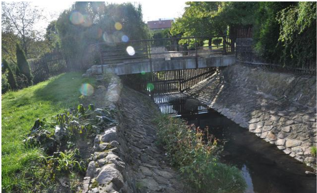
Obr. č. 18 – Přehrazená část potoka (Marešová, 2013)
