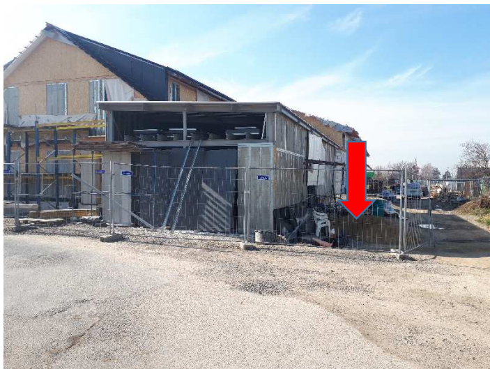
Obr. 4 Stavba rodinného domu a důsledek zničení bodu č. 523; zdroj [foto autora práce]
