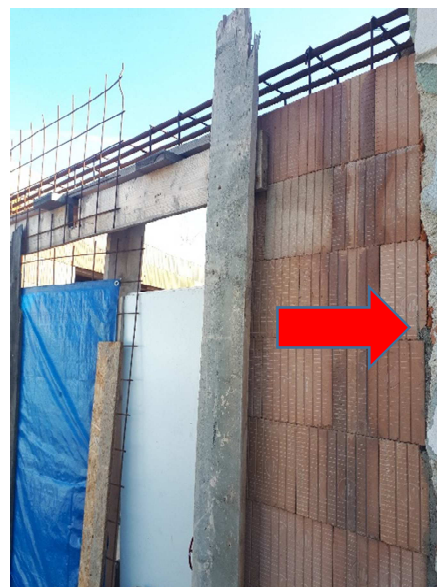
Obr. 5 Bod č. 549, který je rohem rekonstruovaného domu; zdroj [foto autora práce]
