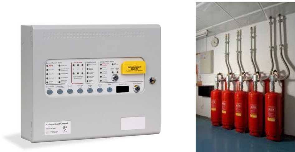
Obrázek 5-16 SHZ ústředna Sigma XT, láhve s hasivem FM200 [28]
