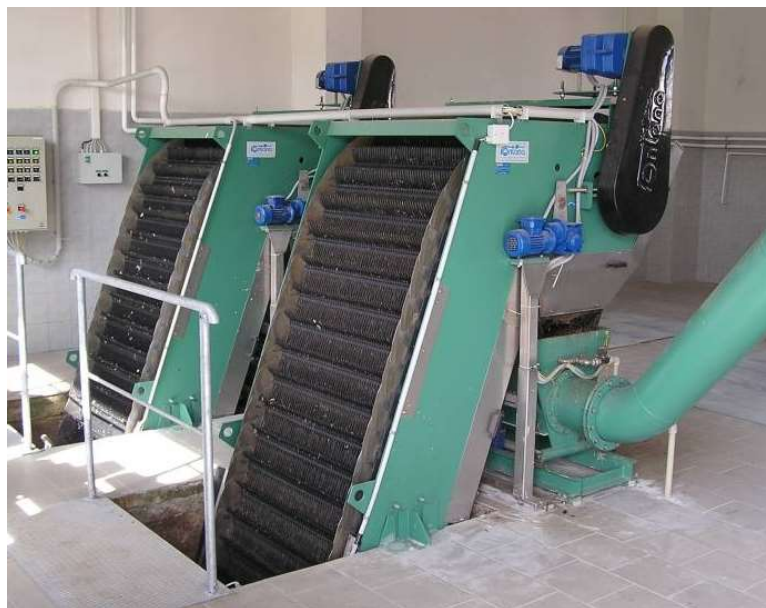
Obr. 6: Samočisticí česle [8]
