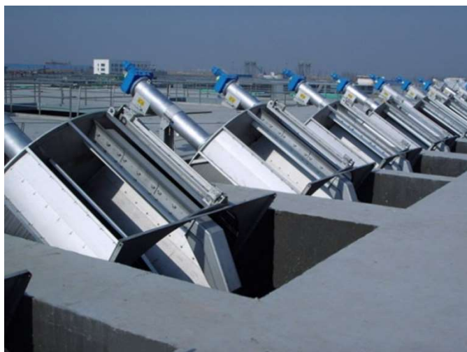
Obr. 8: Česle bubnové rotační [14]
