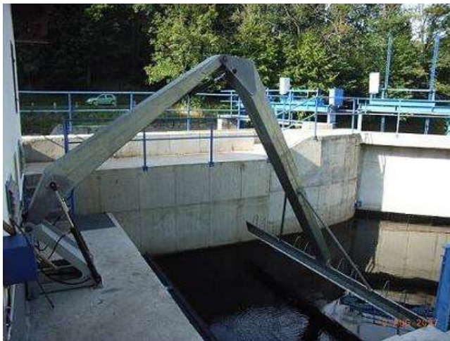
Obr. 11: Česle hydraulické kloubové dvouramenné[17]
