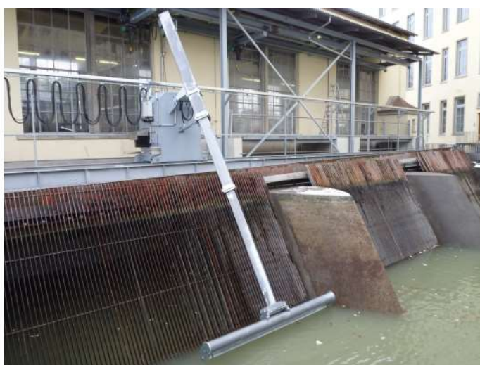
Obr. 10: Česle hydraulické teleskopické [16]
