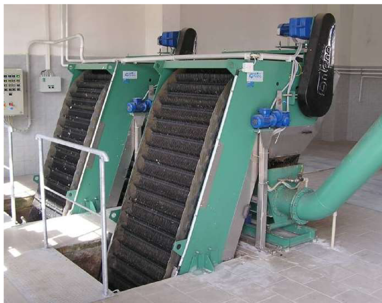
Obr. 6: Samočisticí česle [8]
