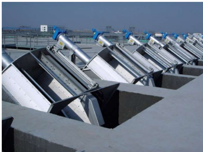
Obr. 8: Česle bubnové rotační [14]
