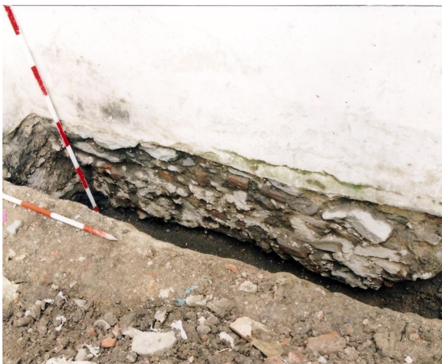
Tabulka č. 20 Olomouc – 8. května, akce 3/2005, Sonda S3, J část, základ zdi 900, pohled od SV; (foto: P. Večeřa, NPÚ Olomouc, fotoarchiv – foto č. 132659).
