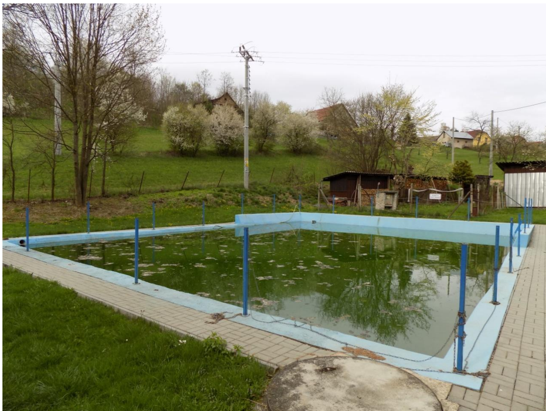
Příloha č.5: Hasičská nádrž – Bolešín (Foto: Libor Vávra, 2016)
