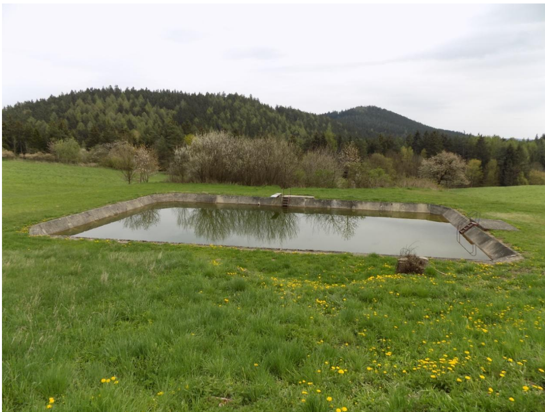
Příloha č.11: Hasičská nádrž – Věstín (Foto: Libor Vávra, 2016)
