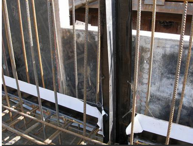
Obrázok 40 - TP osadenie krížového tesniaceho profilu (7)
