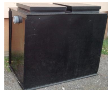
Obrázok 56 - Odlučovač ropných látok (58)
