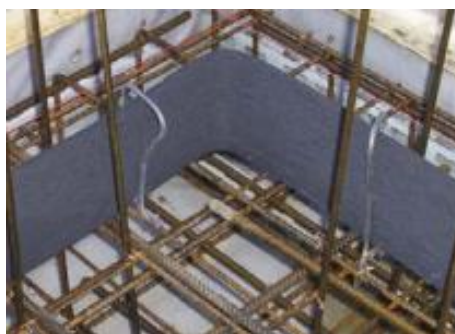
Obrázok 35 - TP osadenie plechového tesniaceho pásu (6)
