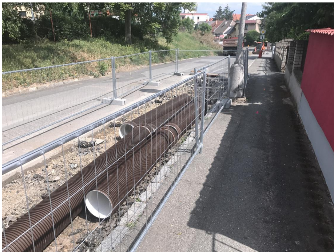
Obrázek 27- Potrubí UltraRib 2 DN 300 SN 16. Zdroj: vlastní práce.
