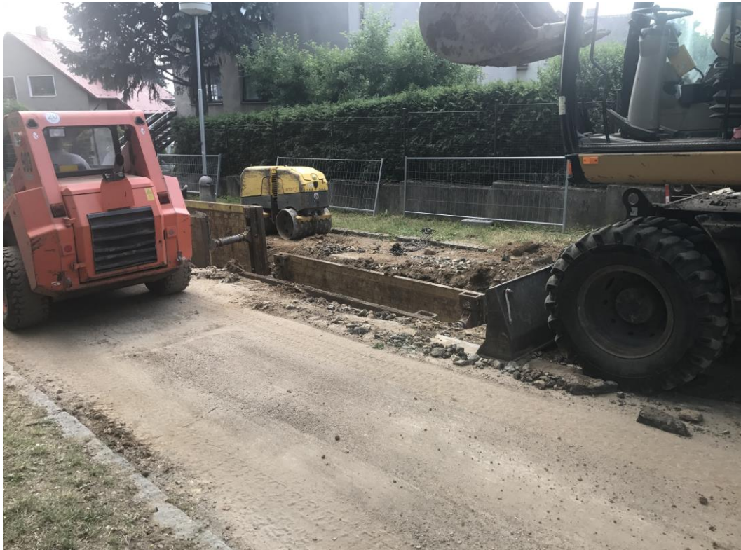
Obrázek 29 - Příklad využitých strojů. Zdroj: vlastní práce
