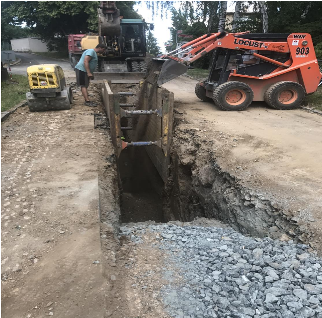
Obrázek 26 - Průběh rekonstrukce v Sudoměřické ulici. Zdroj: vlastní práce.
