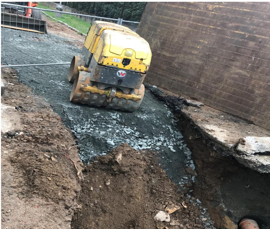
Obrázek 25 - Příklad hutnění. Zdroj: vlastní práce
