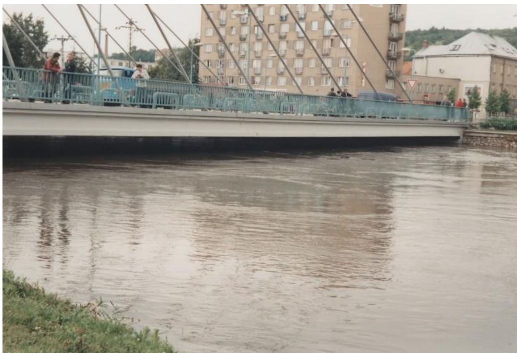
Obr. 3 Povodně z roku 1997 v Židlochovicích
