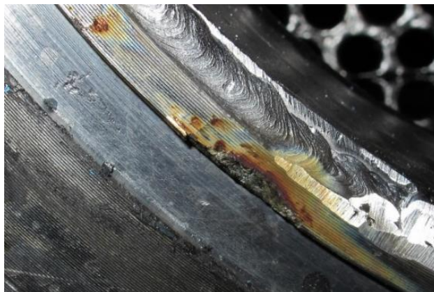
Obr. 6 Ukázka koroze svarového spoje
