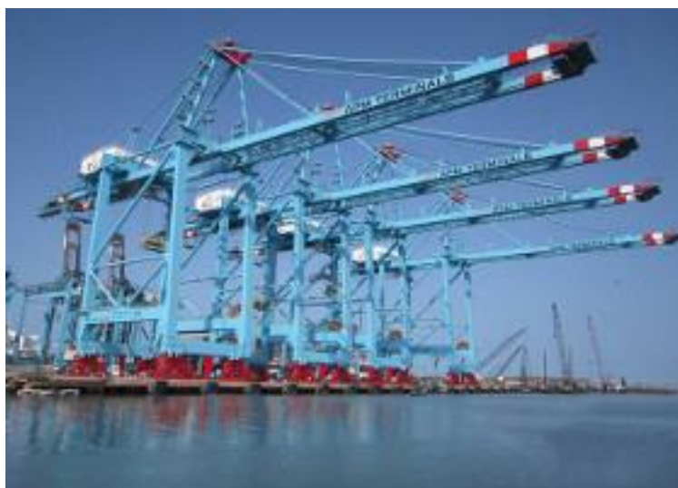
Obr. 18 - Nábřežní kontejnerový jeřáb [26]
