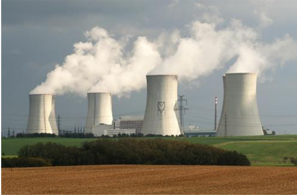
Obr. 6: Chladicí věže JE Dukovany [11]
