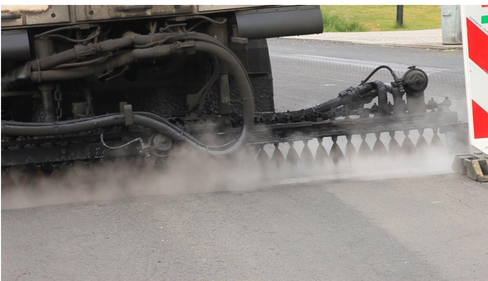
Obr. 2.19 Detail rozstřiku emulze ze ST
