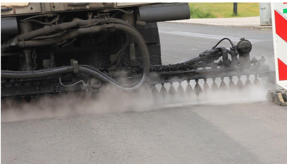
Obr. 2.19 Detail rozstřiku emulze ze ST
