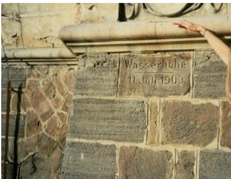
Obr. 24: Dochovaná značka zaznamenávající výšku kulminace vody za katastrofální povodně na řece Opavě v červenci 1903 - na domě v Ratibořské ulici v Opavě (URL 24) Zdroj: Geografické rozhledy, https://www.geograficke-rozhledy.cz/archiv/clanek/434/pdf
