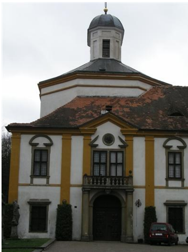
44/ Choltice, zámecká kaple sv. Romedia, 70.-90. léta 17. století, pohled od západu. Foto: Zdeňka Krpálková.
