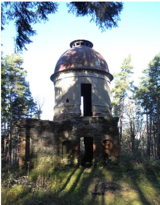
Obr. 3 – Ptačí hrádek před rekonstrukcí.
