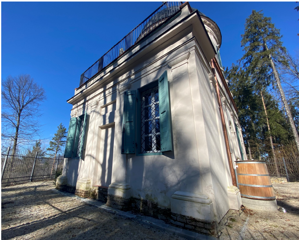
Obr. 5 – Ptačí hrádek, jihozápadní fasáda.
