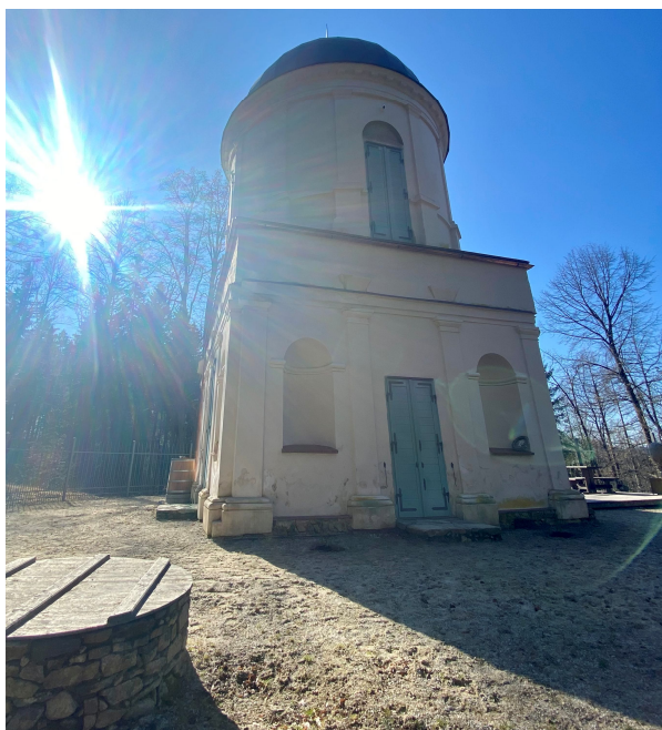
Obr. 4 – Pohled na Ptačí hrádek ze severovýchodu.
