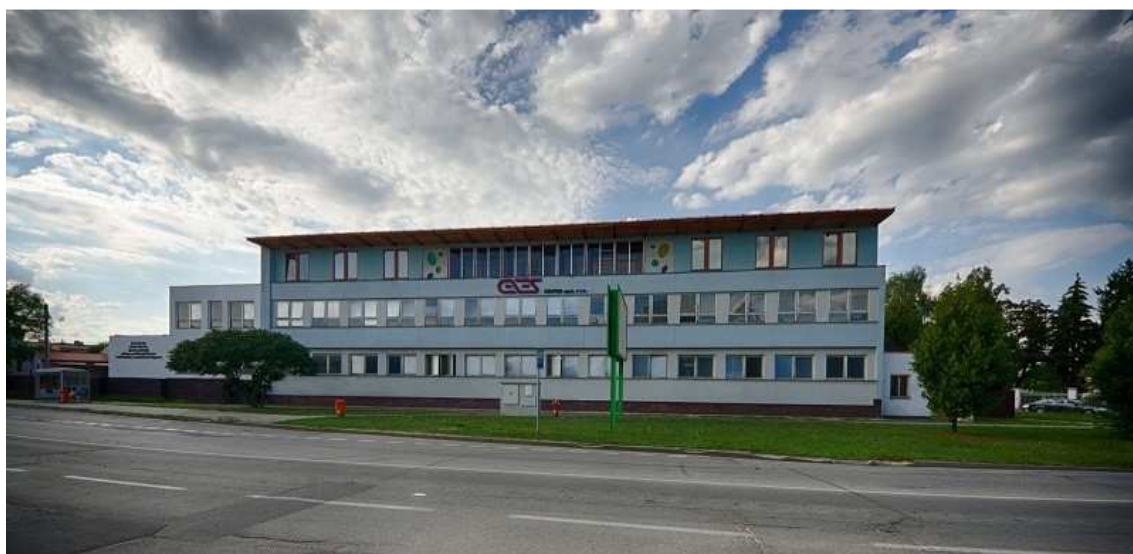
Obrázek 11: Hlavní budova společnosti
