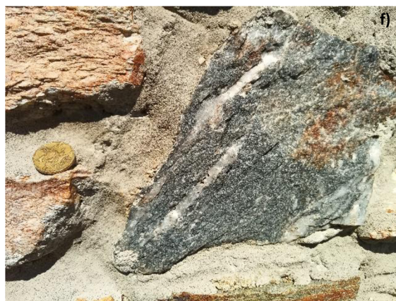
Příloha 1. a) kamenná zeď obepínající kostel s hřbitovem, b) vápenec, c) fylit, d) metabazit, e) křemenný metakonglomerát, f) kvarcit (20 Kč jako měřítko) (foto 21.4.2022)
