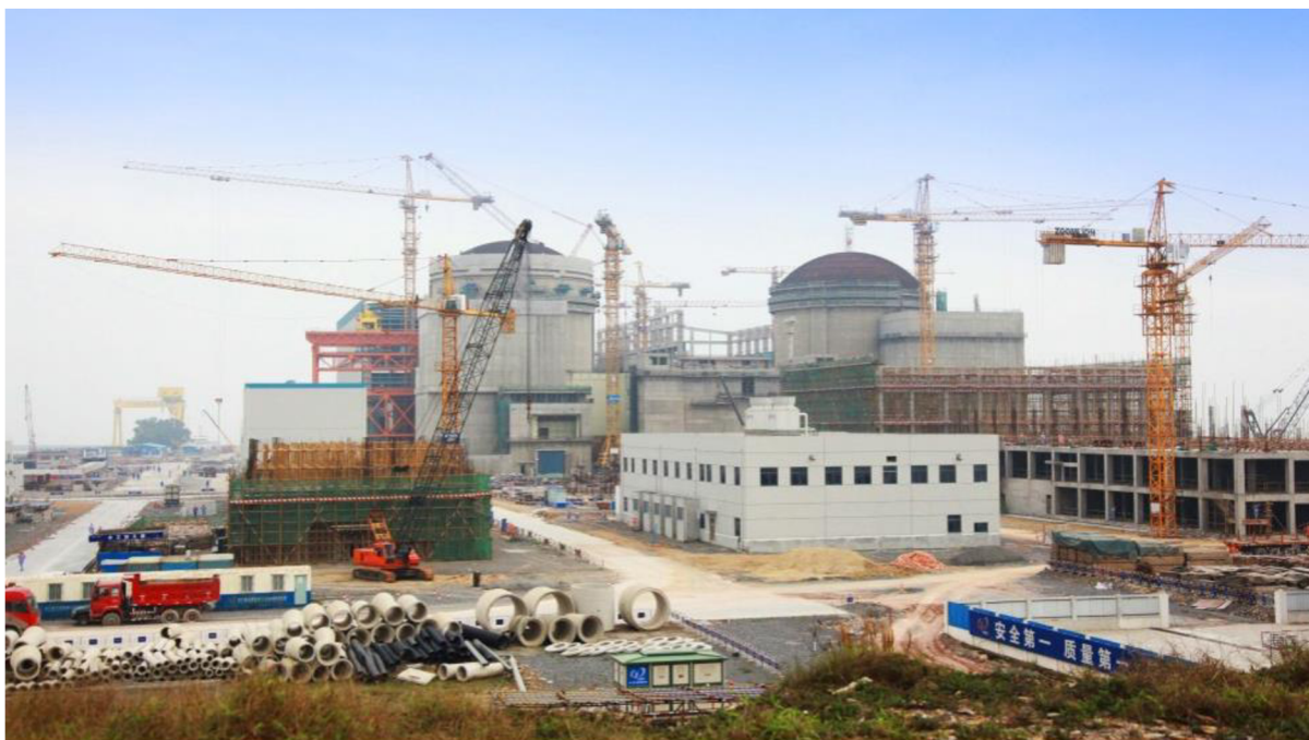
Figure 17: Najmodernejšia čínska atómová elektrárň [20]
