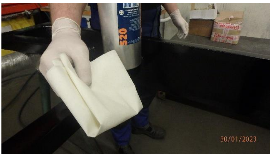
Obrázek 20. Čištění povrchu rámu
