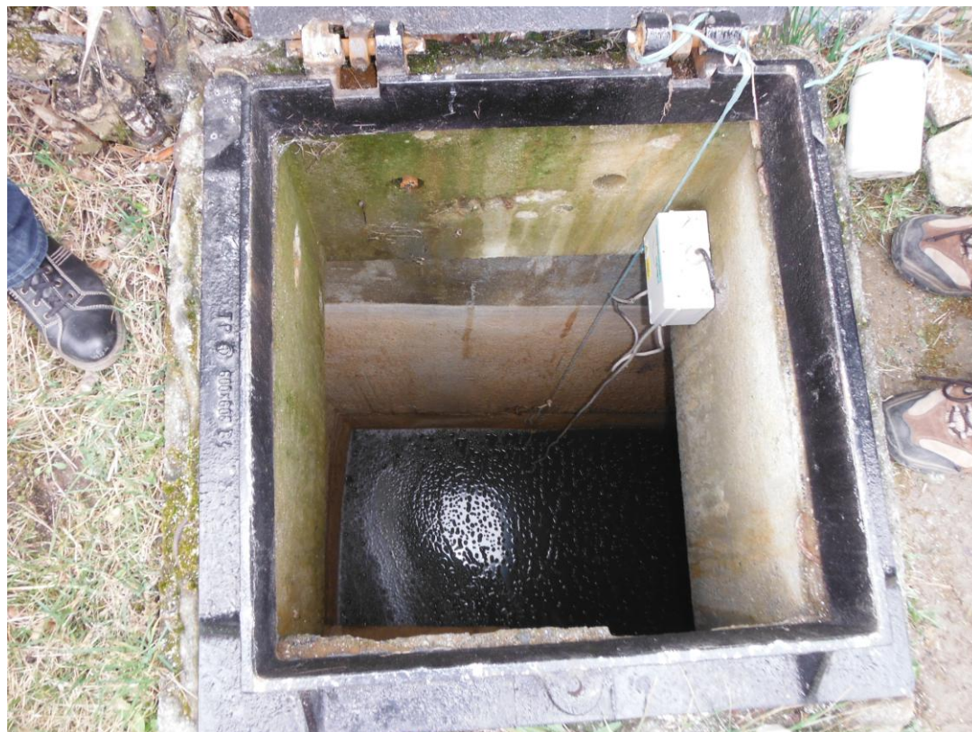
Obr. 4.22 Kalová jímka (odtok vody z kalolisu) na ÚV Nová Ves u Frýdlantu [zdroj: Ilona Ševčíková]
