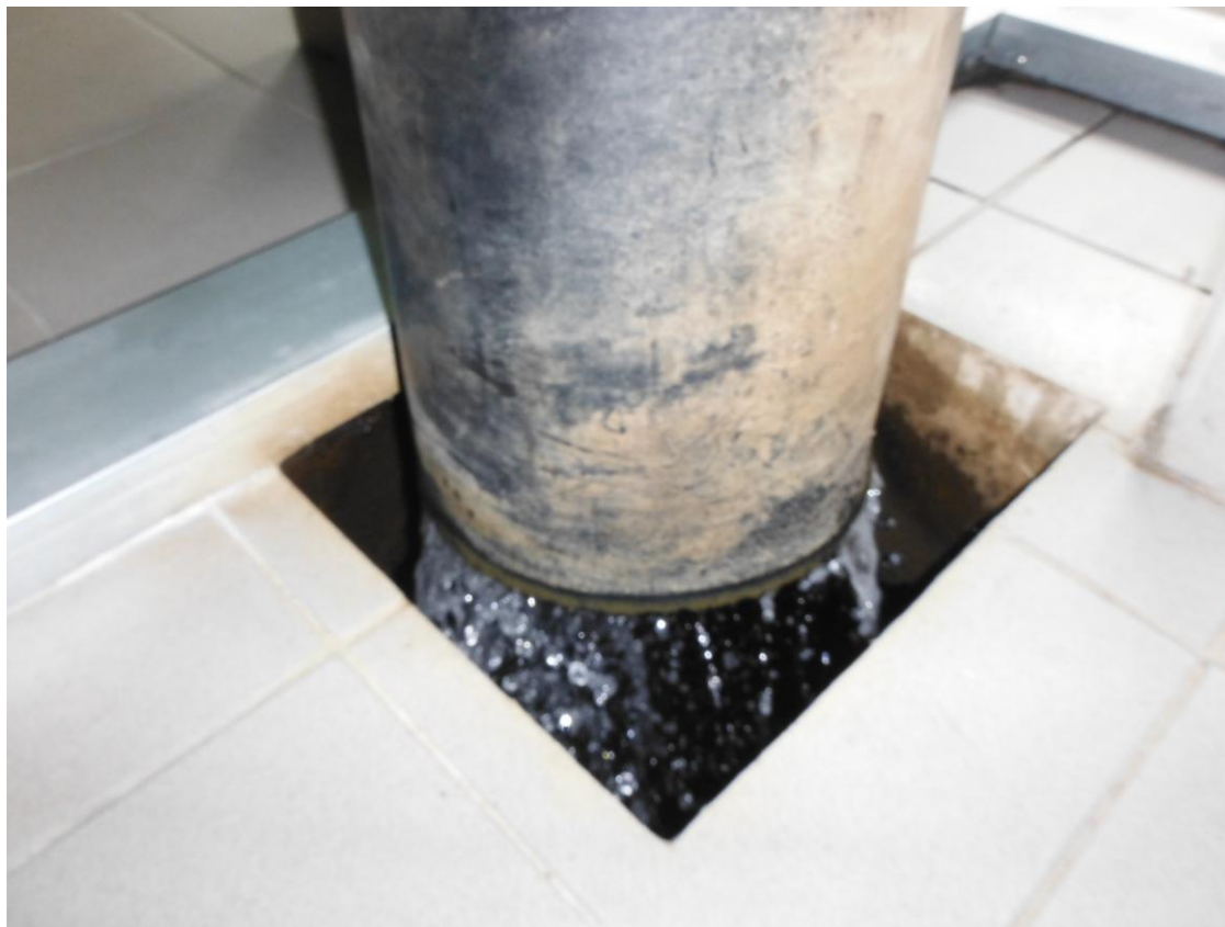
Obr. 4.14 Odtok fugátu z odstředivky na ÚV Podhradí [zdroj: Ilona Ševčíková]
