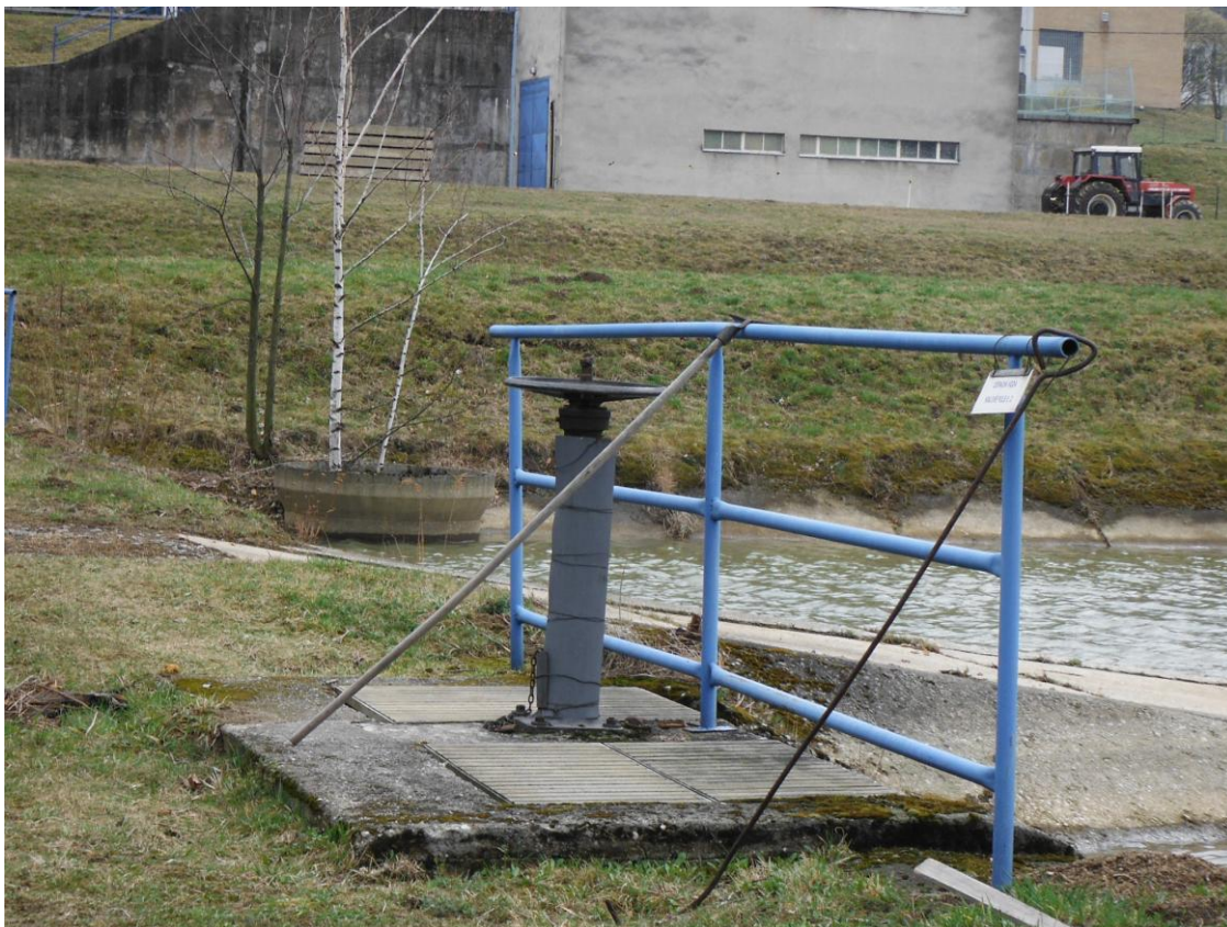
Obr. 4.25 Odtok vody z kalové laguny do recipientu na ÚV Nová Ves u Frýdlantu [zdroj: Ilona Ševčíková]
