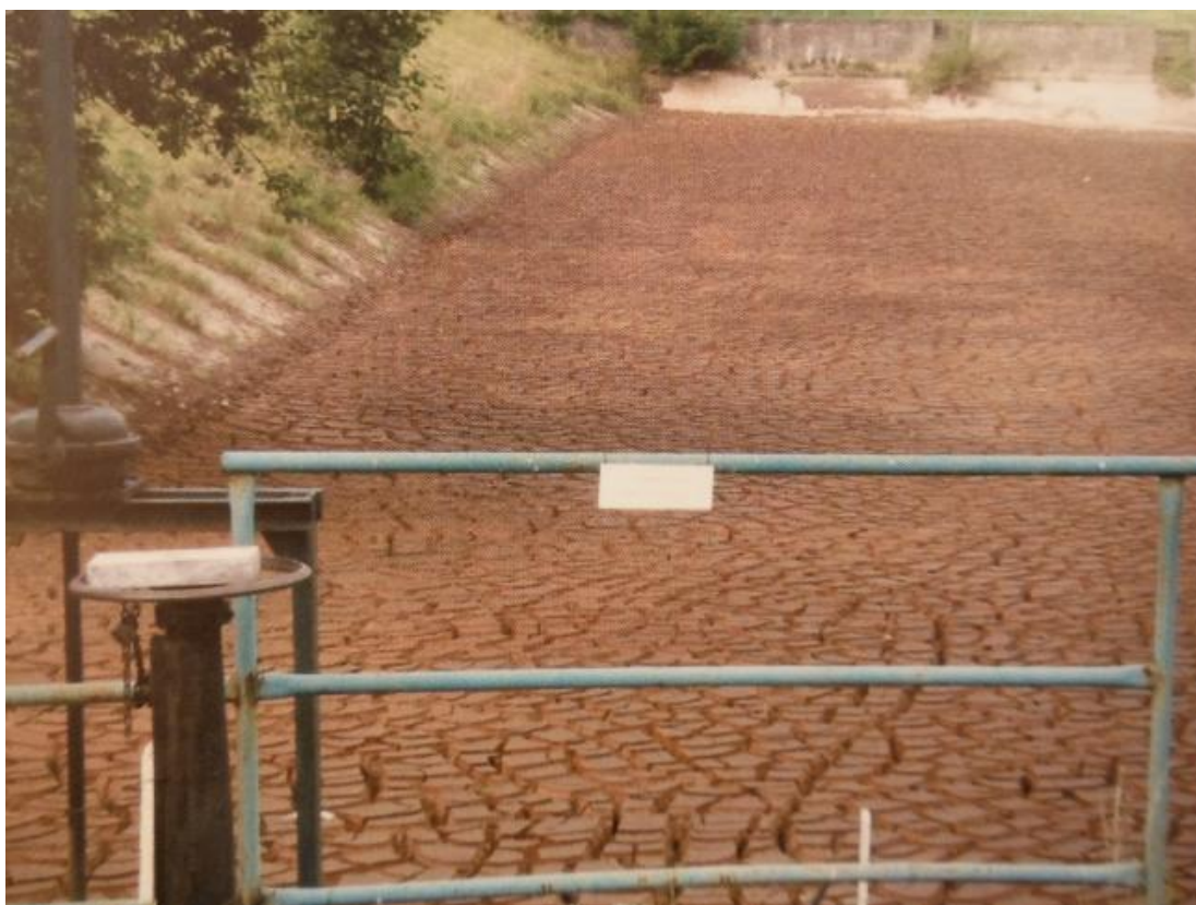
Obr. 3.7 Kalová laguna po vysušení a vymrznutí [1]
