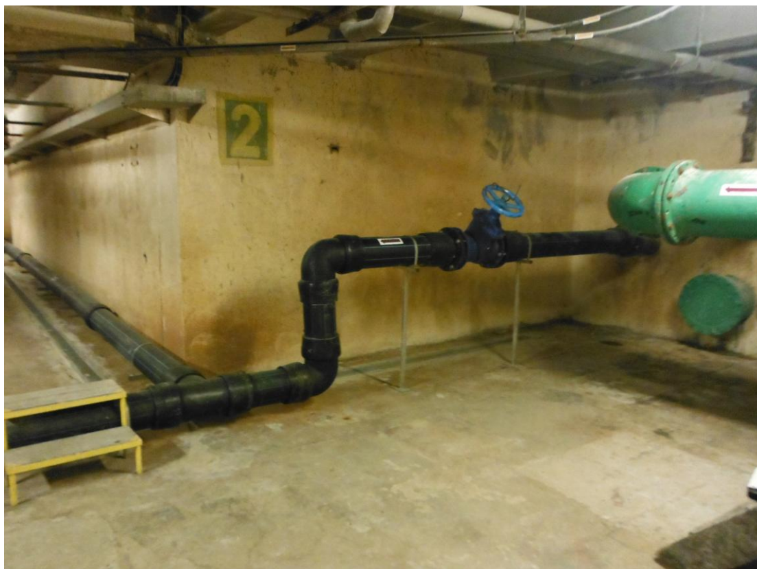
Obr. 4.4 Odkalovací potrubí na ÚV Ostrava - Nová Ves [zdroj: Ilona Ševčíková]
