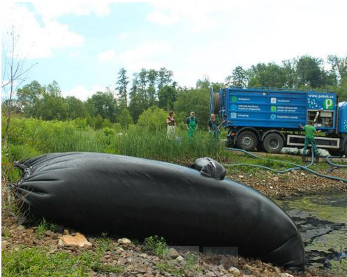
Obr. 3.8 Odvodňovací vak [6]
