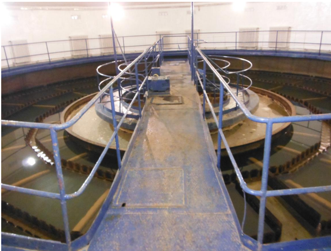
Obr. 4.3 Sedimentační nádrž - pohled zevnitř na ÚV Ostrava - Nová Ves [zdroj: Ilona Ševčíková]
