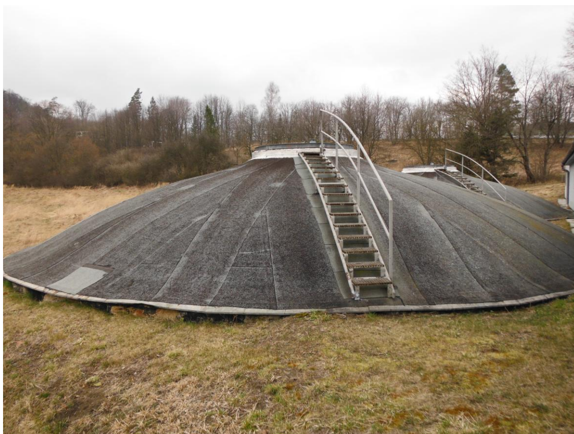
Obr. 4.12 Usazovací nádrž na ÚV Podhradí [zdroj: Ilona Ševčíková]
