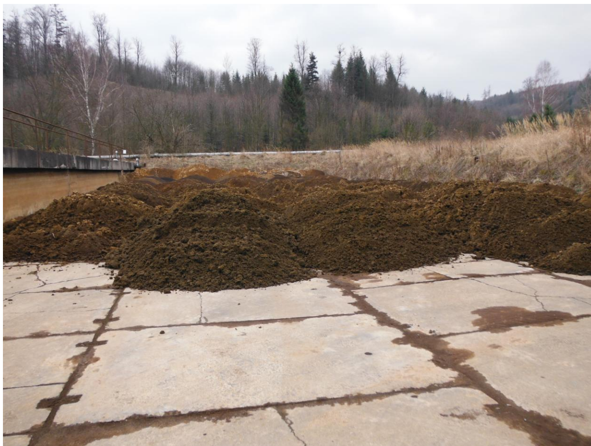
Obr. 3.4 Kalové pole [zdroj: Ilona Ševčíková]
