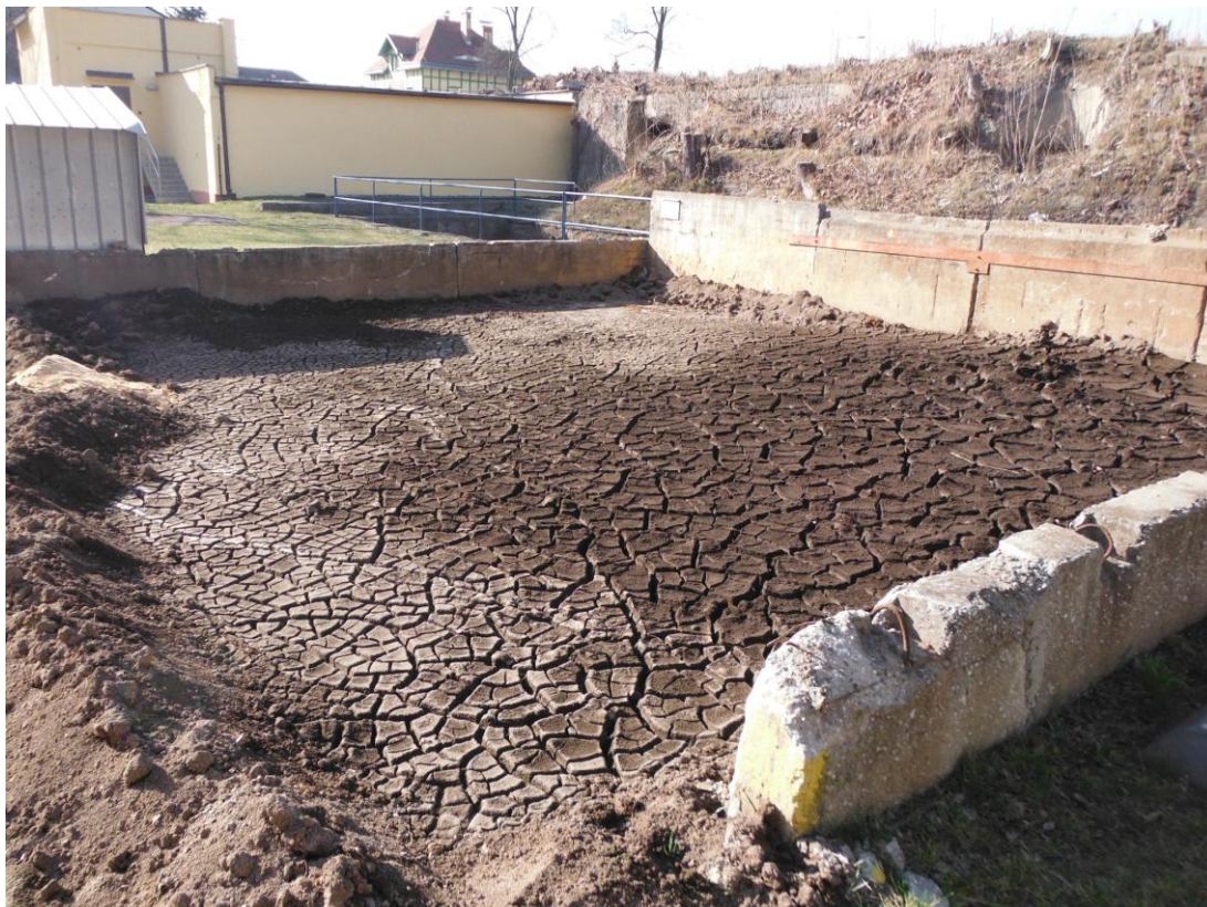
Obr. 4.7 Odvodňovací plocha kalů (kalové pole) na ÚV Ostrava - Nová Ves [zdroj: Ilona Ševčíková]
