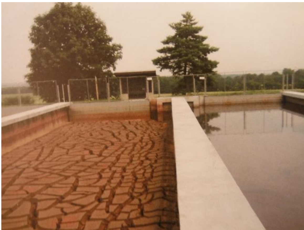
Obr. 4.27 Dvojice kalových polí - levé vypuštěné, pravé po napuštění [1]
