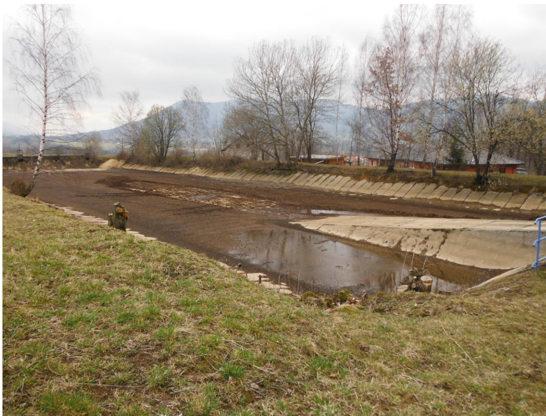
Obr. 4.24 Kalová laguna na ÚV Nová ves u Frýdlantu (částečně vysušený kal) [zdroj: Ilona Ševčíková]
