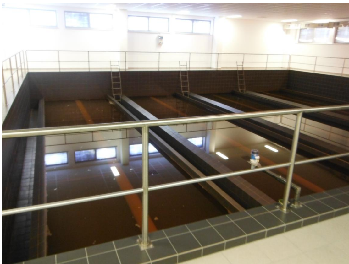
Obr. 4.30 Otevřené rychlofiltry na ÚV Kroměříž [zdroj: Ilona Ševčíková]
