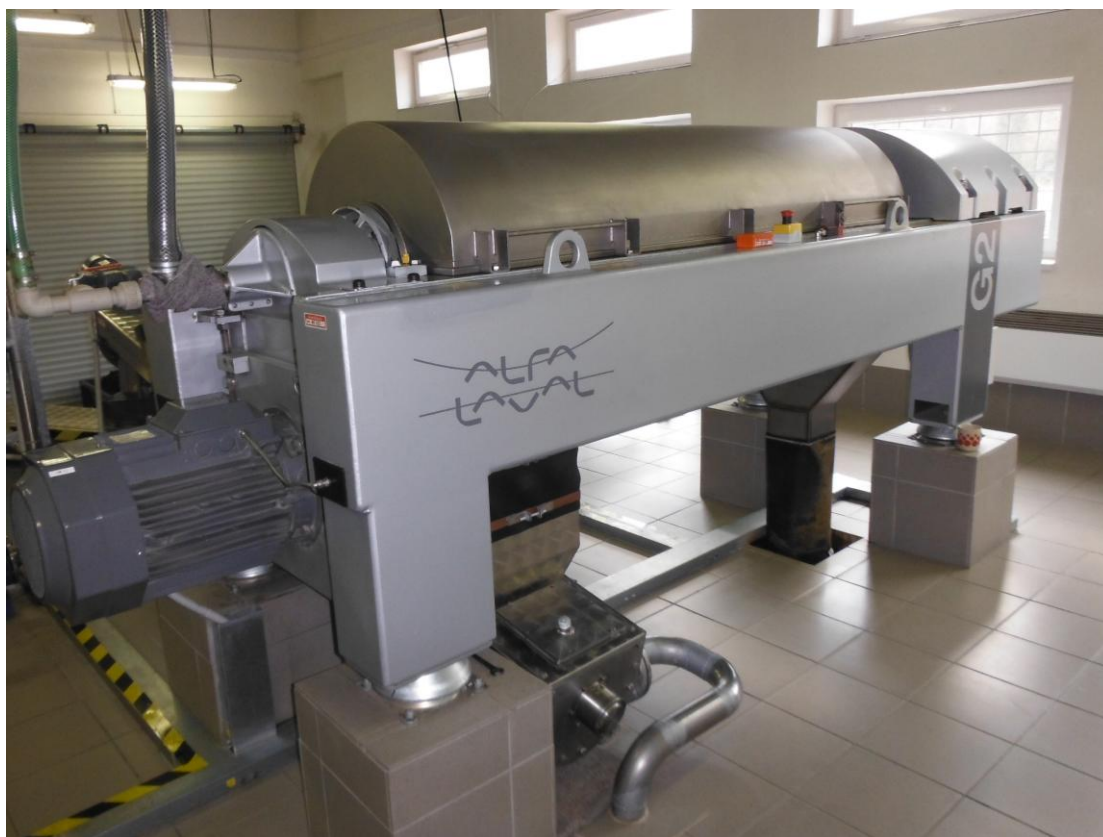
Obr. 4.13 Odstředivka na ÚV Podhradí [zdroj: Ilona Ševčíková]
