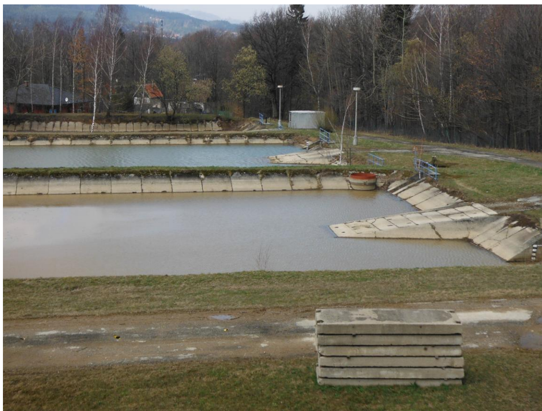
Obr. 4.23 Kalové laguny na ÚV Nová Ves u Frýdlantu [zdroj: Ilona Ševčíková]
