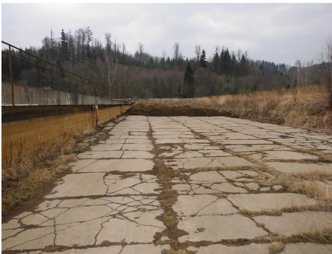
Obr. 4.16 Jedno z kalových polí na ÚV Podhradí [zdroj: Ilona Ševčíková]
