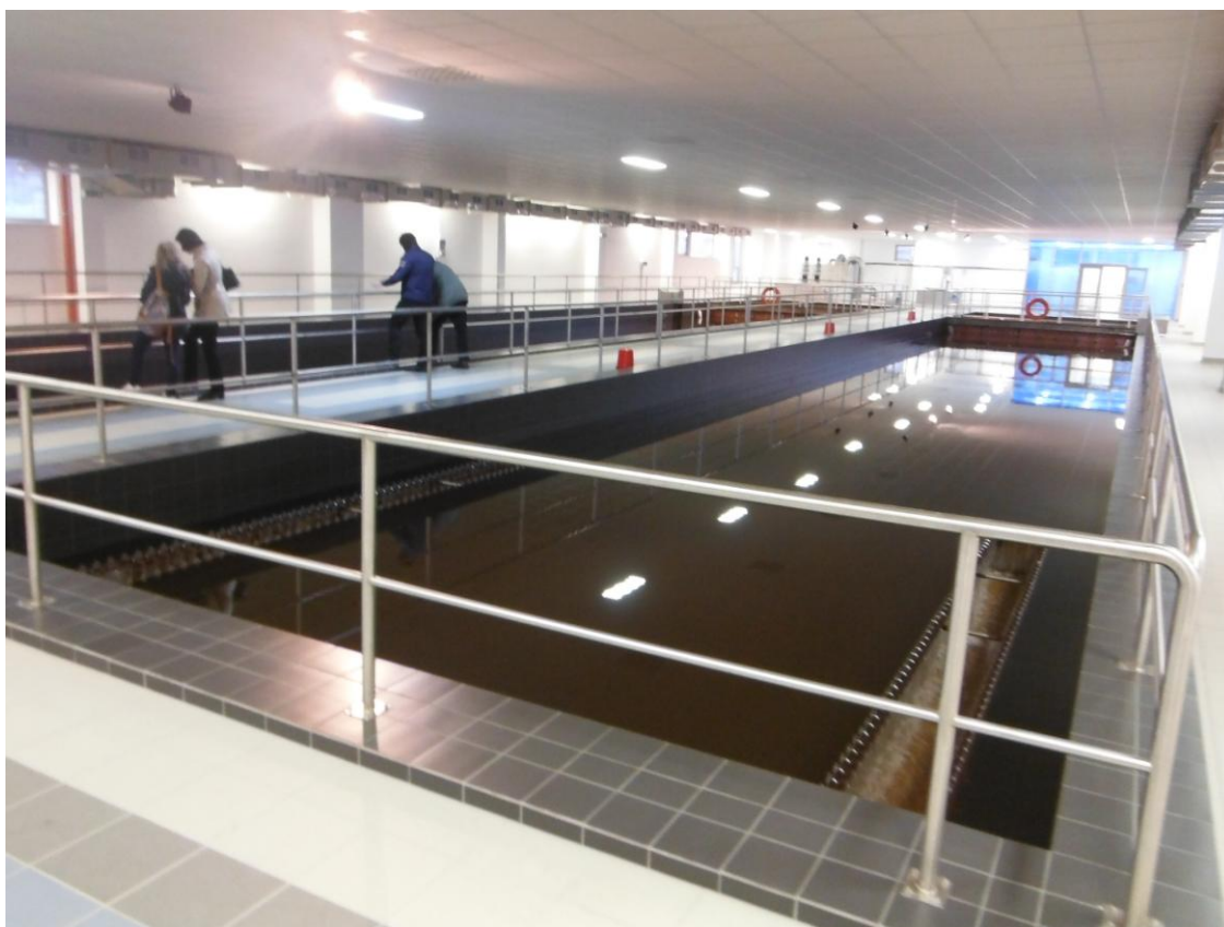
Obr. 4.29 Usazovací nádrž na ÚV Kroměříž [zdroj: Ilona Ševčíková]
