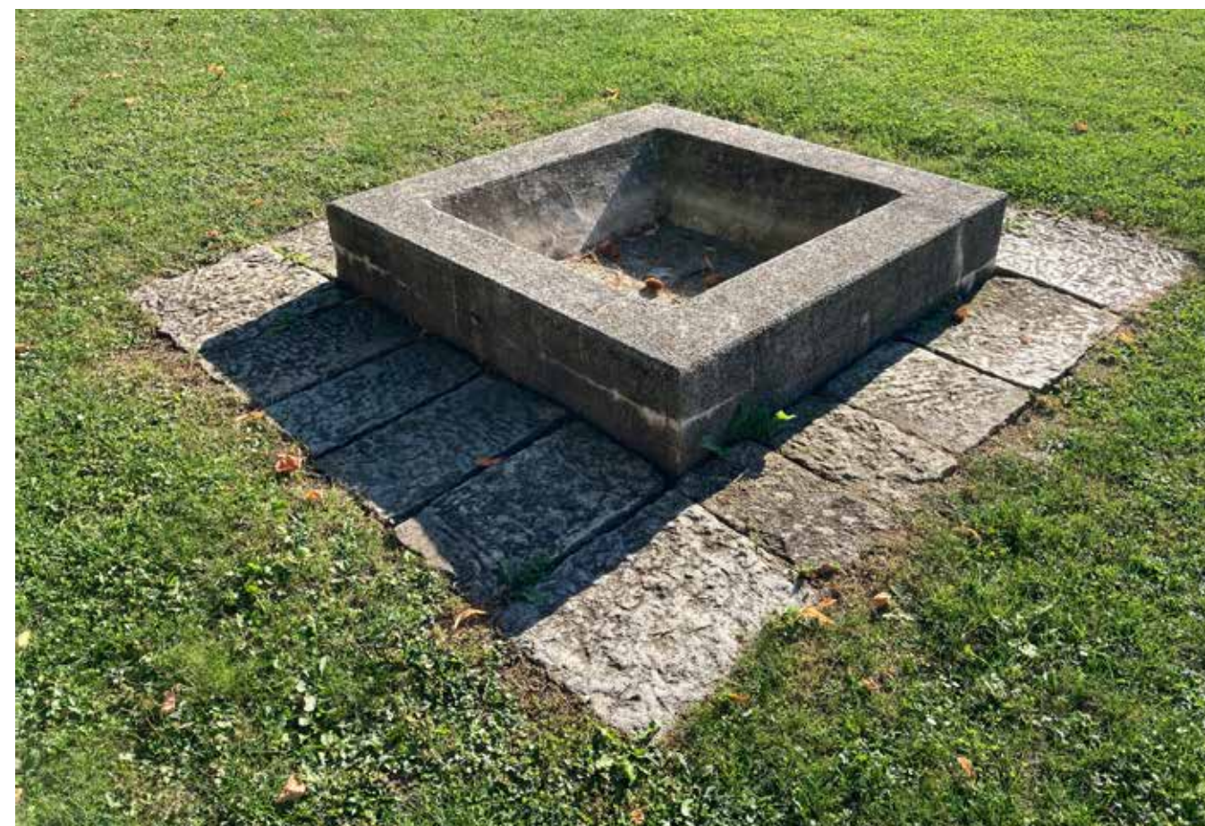
Obr. 114. Současný stav nádrže na vodu. (zdroj: archiv autorky)
