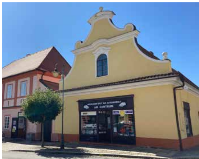
Obr. 104. Nárožní dům č.p. 189. (zdroj: archiv autorky)
