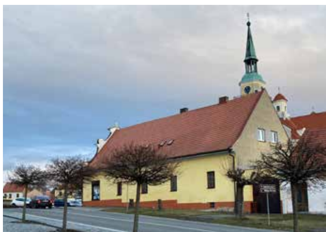
Obr. 105. Nárožní dům č.p. 189. (zdroj: archiv autorky)
