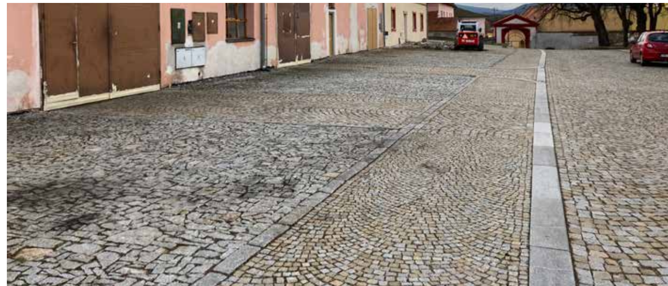
Obr. 186. Stávající dlažba ve dvoře pivovaru - vějířová dlažba menšího a většího formátu. (zdroj: archiv autorky)
