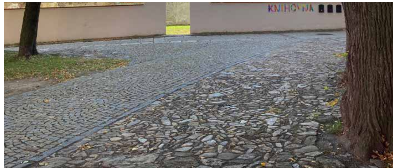
Obr. 187. Stávající dlažba ve dvoře pivovaru - kombinace vějířové a valounové dlažby. (zdroj: archiv autorky)
