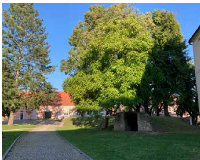
Obr. 139. Vstupní otvor do sklepa u zámku. (zdroj: archiv autorky)
