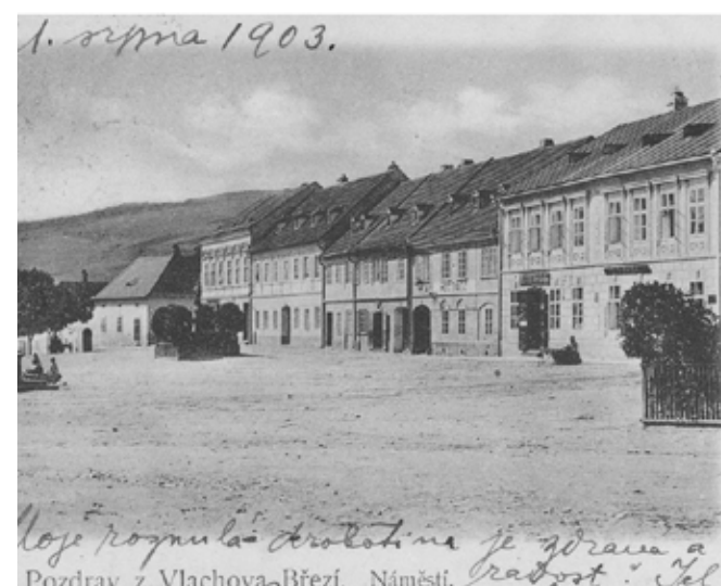
Obr. 43. 1900. Pohled na severozápadní část náměstí. (zdroj: Nováček et al. 2017)
