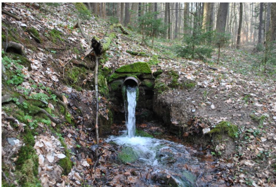
Obr. č. 7 Ústí dědičné štoly na břehu Stráleckého potoka (Foto: M. Polášková, 2013)
