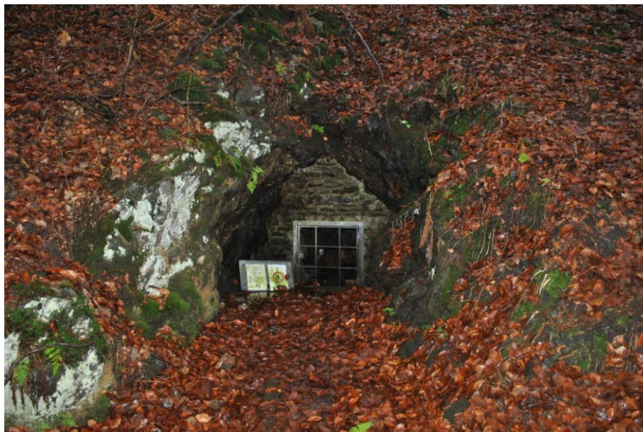
Obr. č. 13 Štola pod kótou Ostrý (Foto: M. Polášková, 2013)
