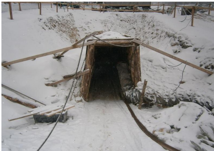
Obr. č. 17 Ústí štoly sv. Antonína Paduánského (Foto: Baňská ZS, 2013)
