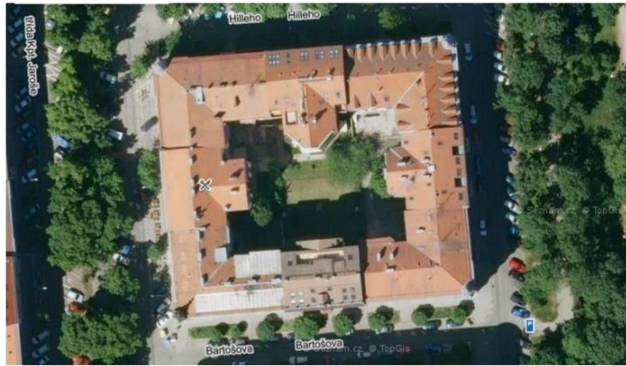
Obrázek 7: Soukromý vnitroblok, Třída Kapitána Jaroše, Brno
