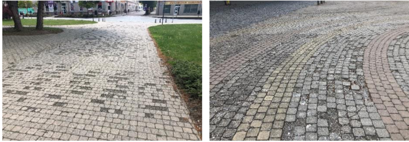
Obrázek 28: Poškozená dlažba
