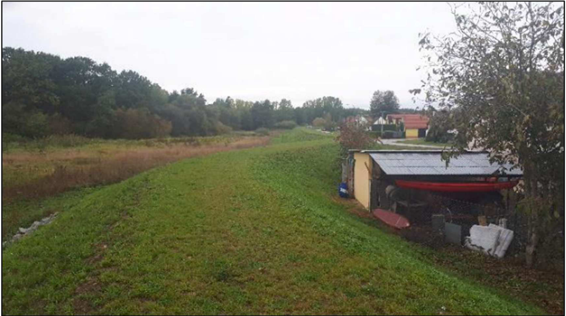
Příloha 10: Protipovodňová hráz ve Staré Hlíně - jižní část (VRV, 2019)
