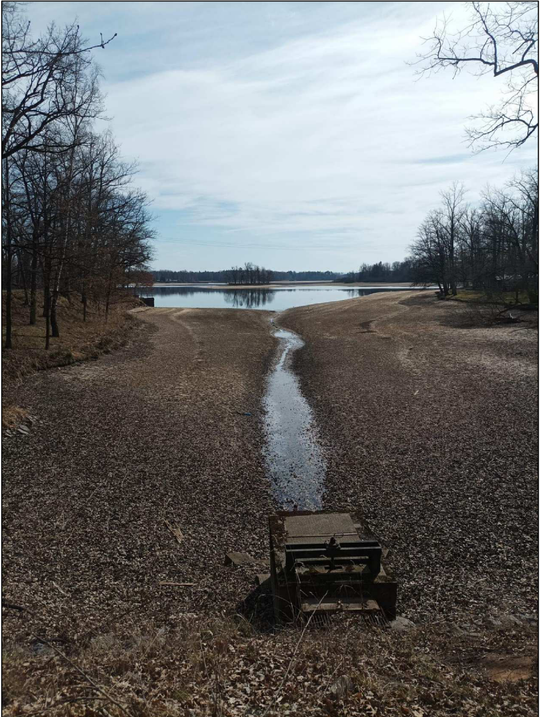
Příloha 5: Téměř vypuštěný Opatovický rybník a jeho trubní propojení s rybníkem Svět, foceno dne 18. 3. 2023 (Jurková, 2023)
