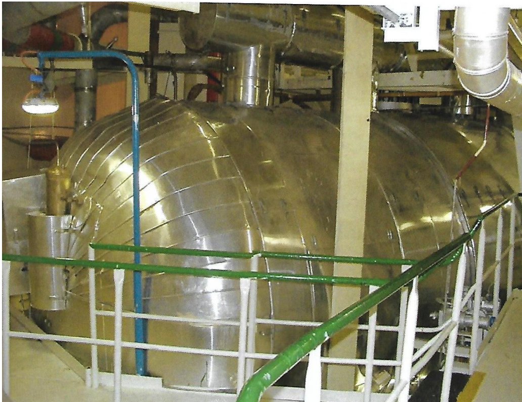
Obr. 3.5 Parogenerátor JE Dukovany [14]
