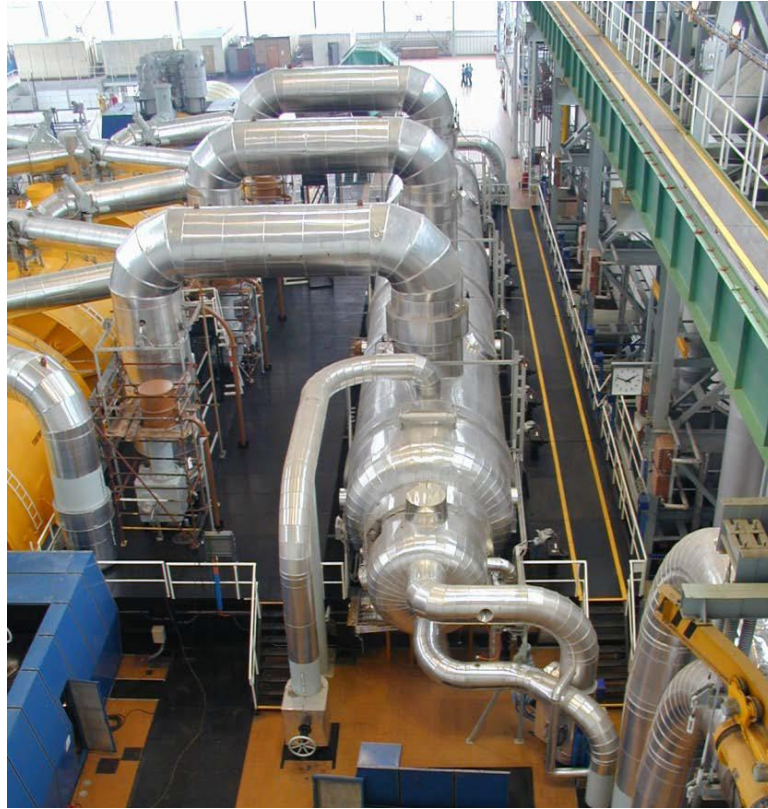
Obr. 3.7 Systém separace a přehřívání páry [23]
