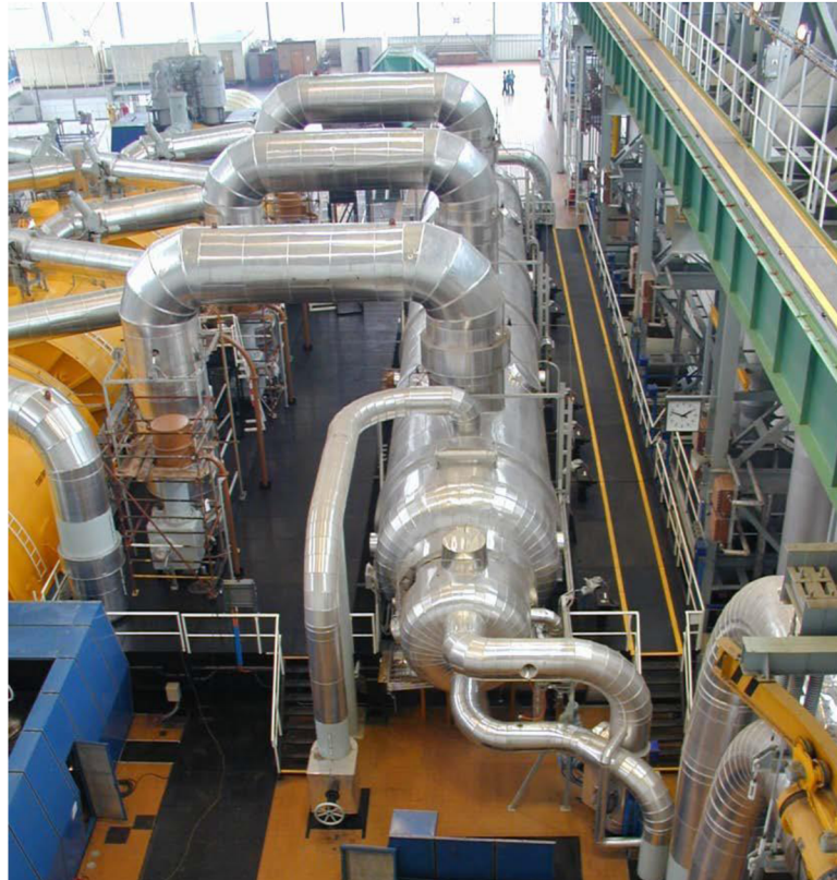
Obr. 3.7 Systém separace a přehřívání páry [23]
