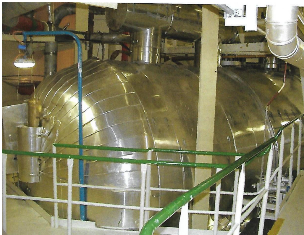
Obr. 3.5 Parogenerátor JE Dukovany [14]
