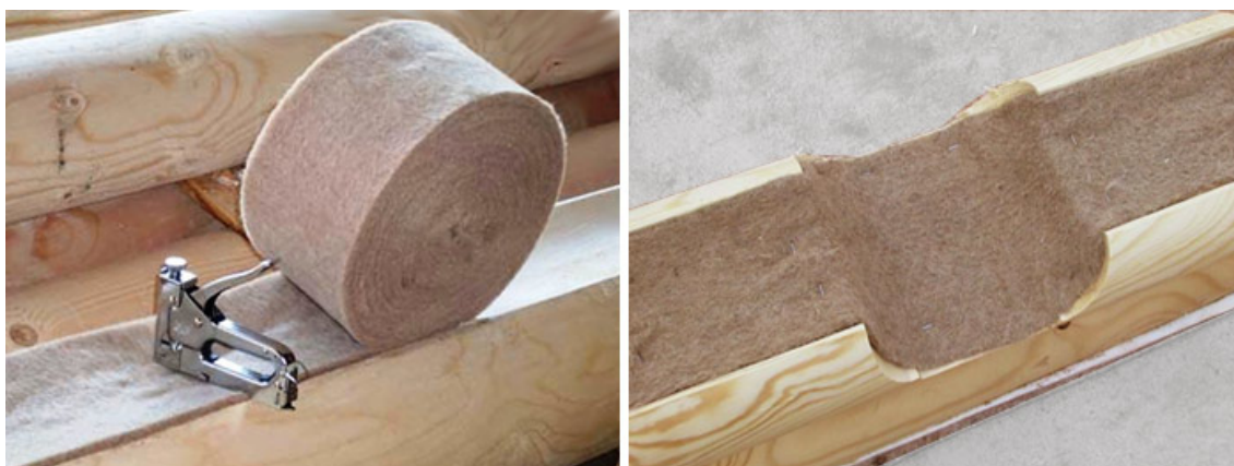
Obrázek 4. Tepelně izolační materiál v mezerách (Derevyanny dom, 2017)
