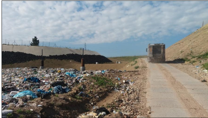
Obrázek 10: Skládka Těmice- panelová cesta (Walachová, 2016)
