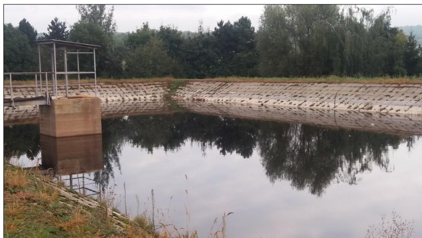
Jímka II. etapy- jímka průsakových vod (WALACHOVÁ, 2016)
