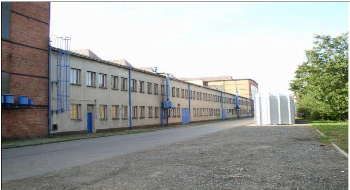
Obr. 2 Stávající stav budovy pohled severní strana
