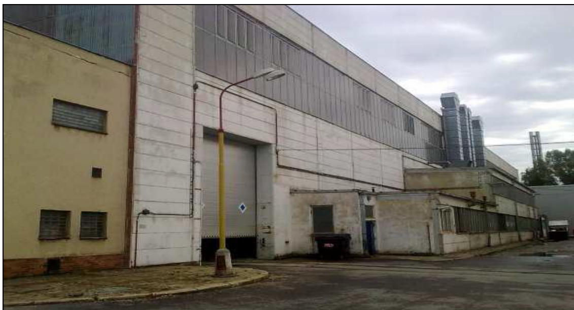
Obr. 3 Stávající stav budovy pohled jižní strana
