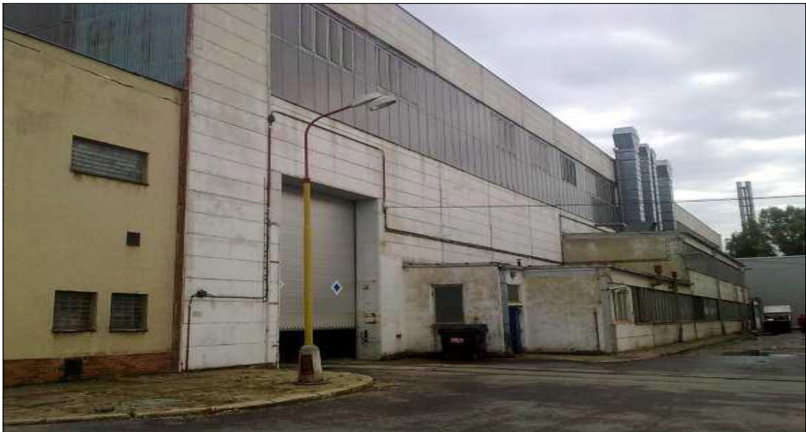
Obr. 3 Stávající stav budovy pohled jižní strana
