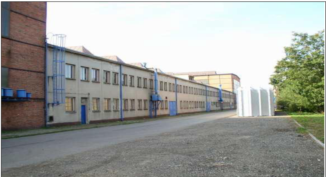
Obr. 2 Stávající stav budovy pohled severní strana
