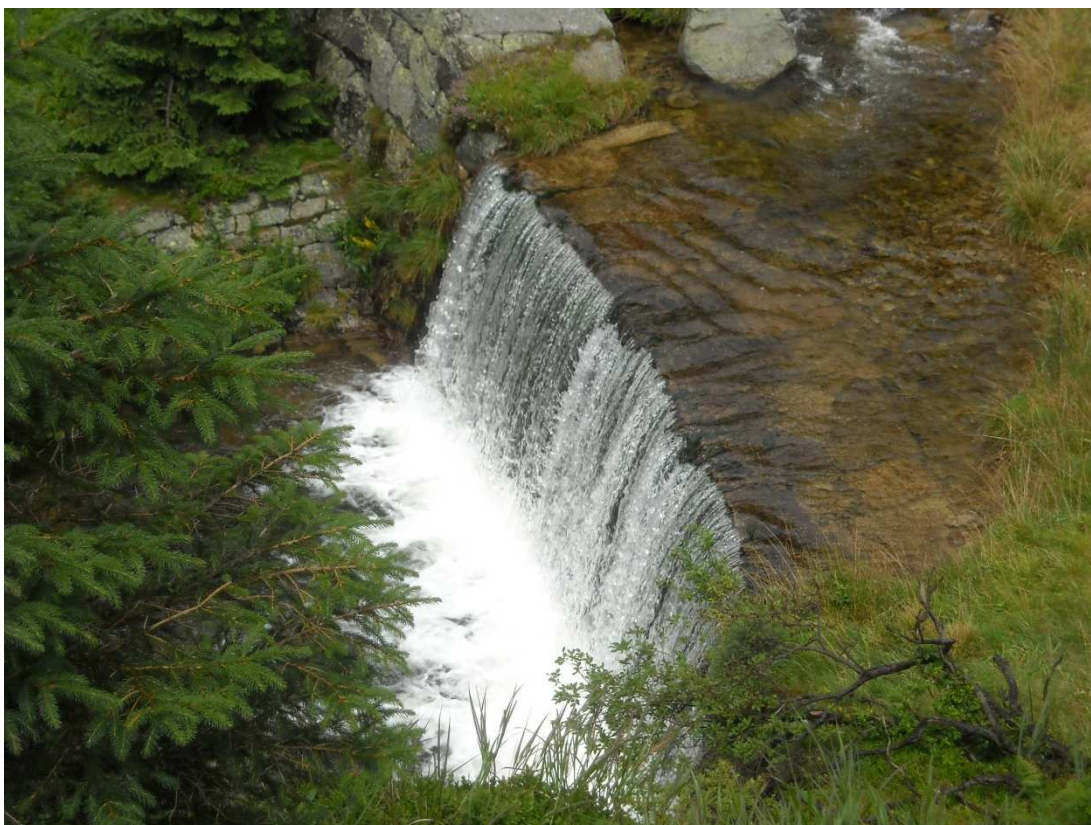
Obrázek č. 10 - Kamenný stupeň v korytě Bílého Labe. Foto: autor
