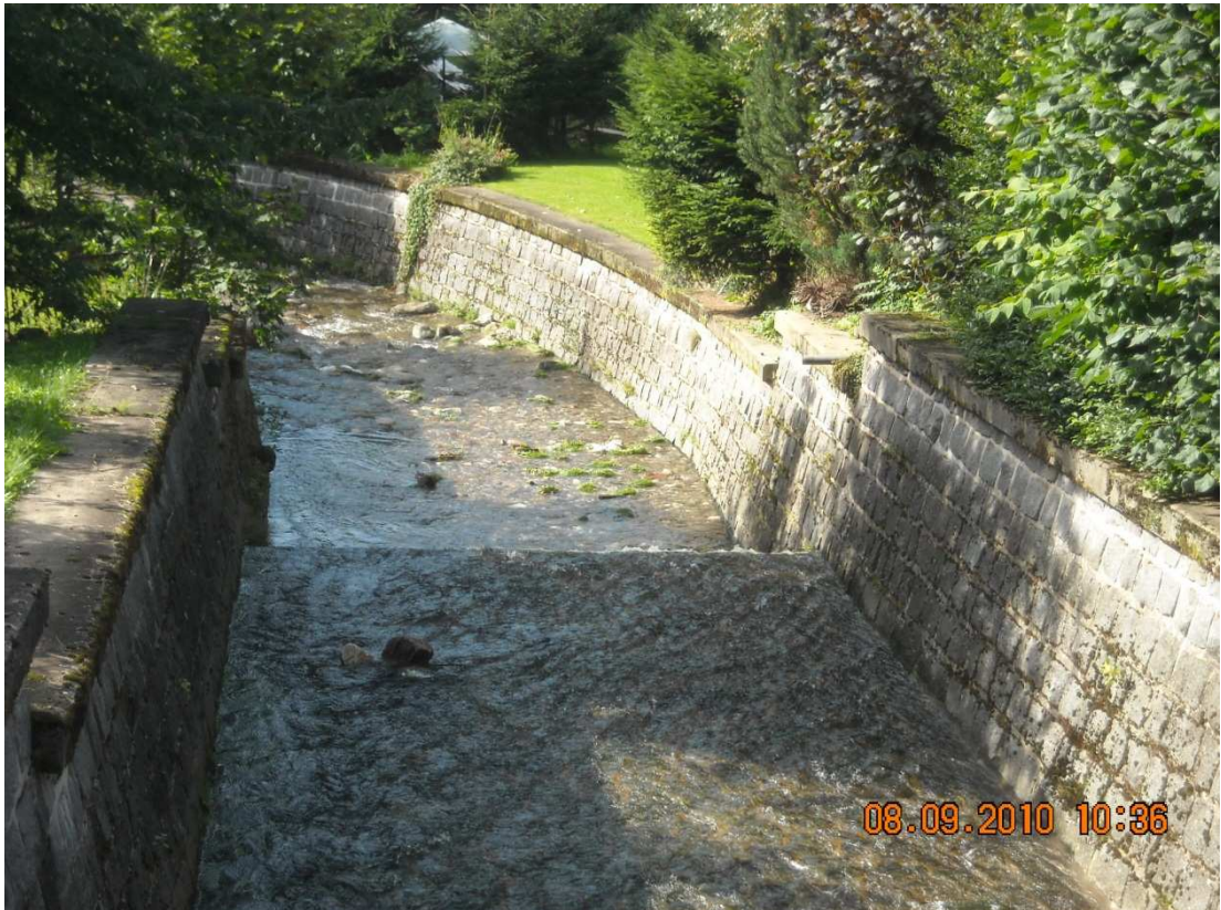
Obrázek č. 1 - Hladce opevněné upravené koryto se spádovým objektem pro tlumení energie vodního proudu v obci Černý důl (Čistá). Foto: autor.
