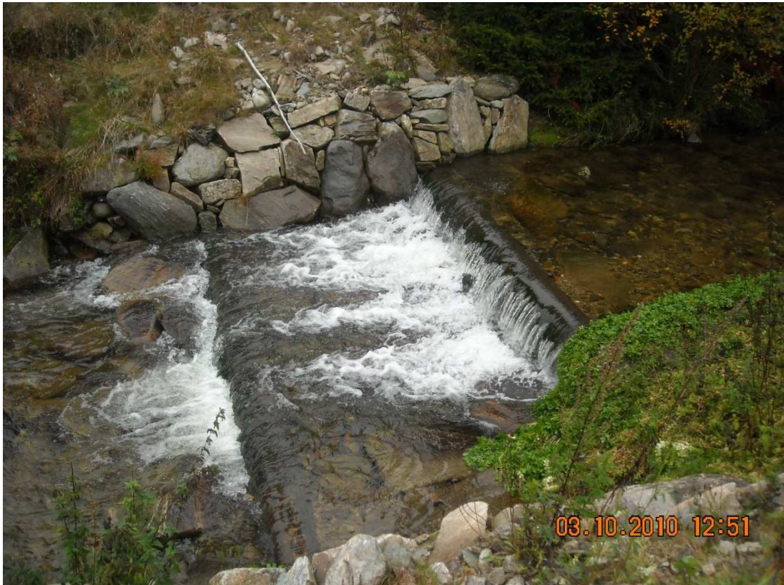
Obrázek č. 2 - Příklad použití dřevěné kulatiny při stavbě prahu (Malá Úpa). Foto: autor.
