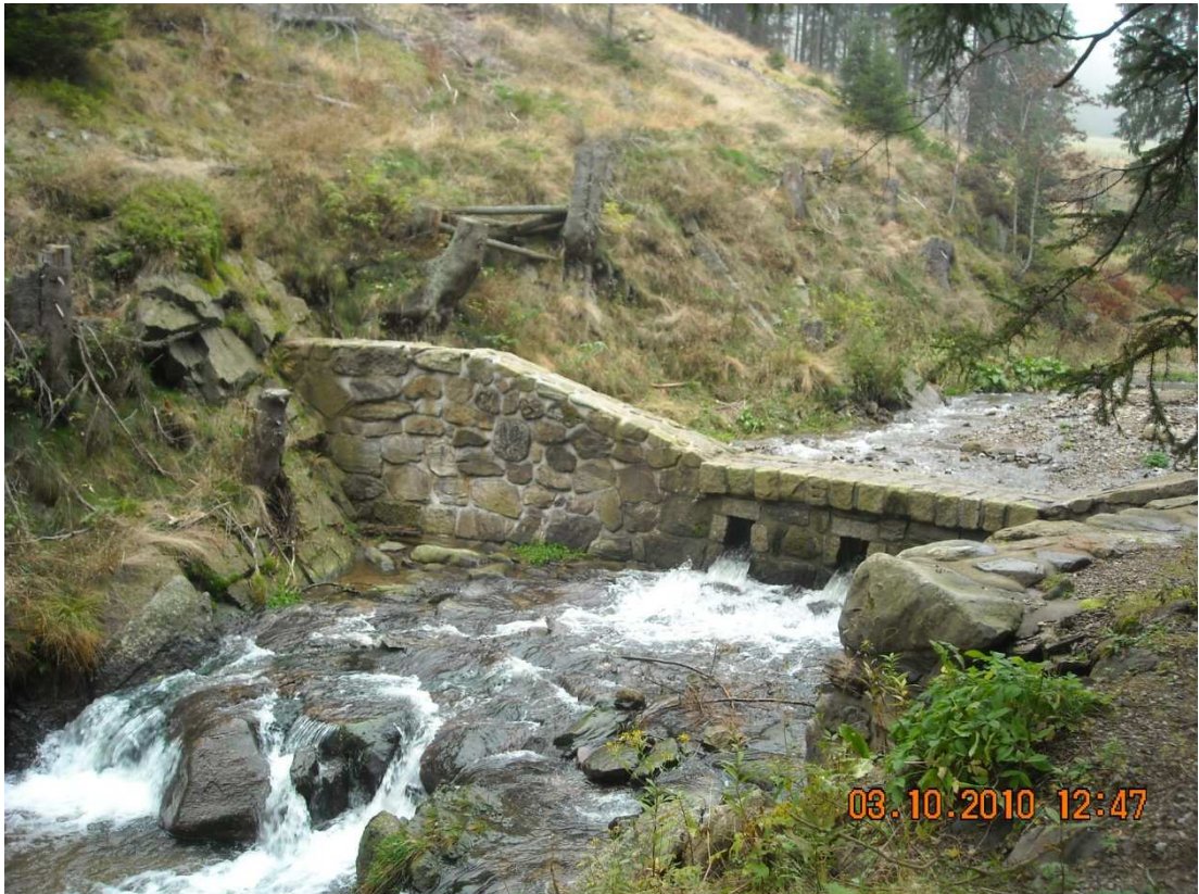
Obrázek č. 5 - Přehrážka na řece Malá Úpa (obec Horní Malá Úpa). Foto: autor.
