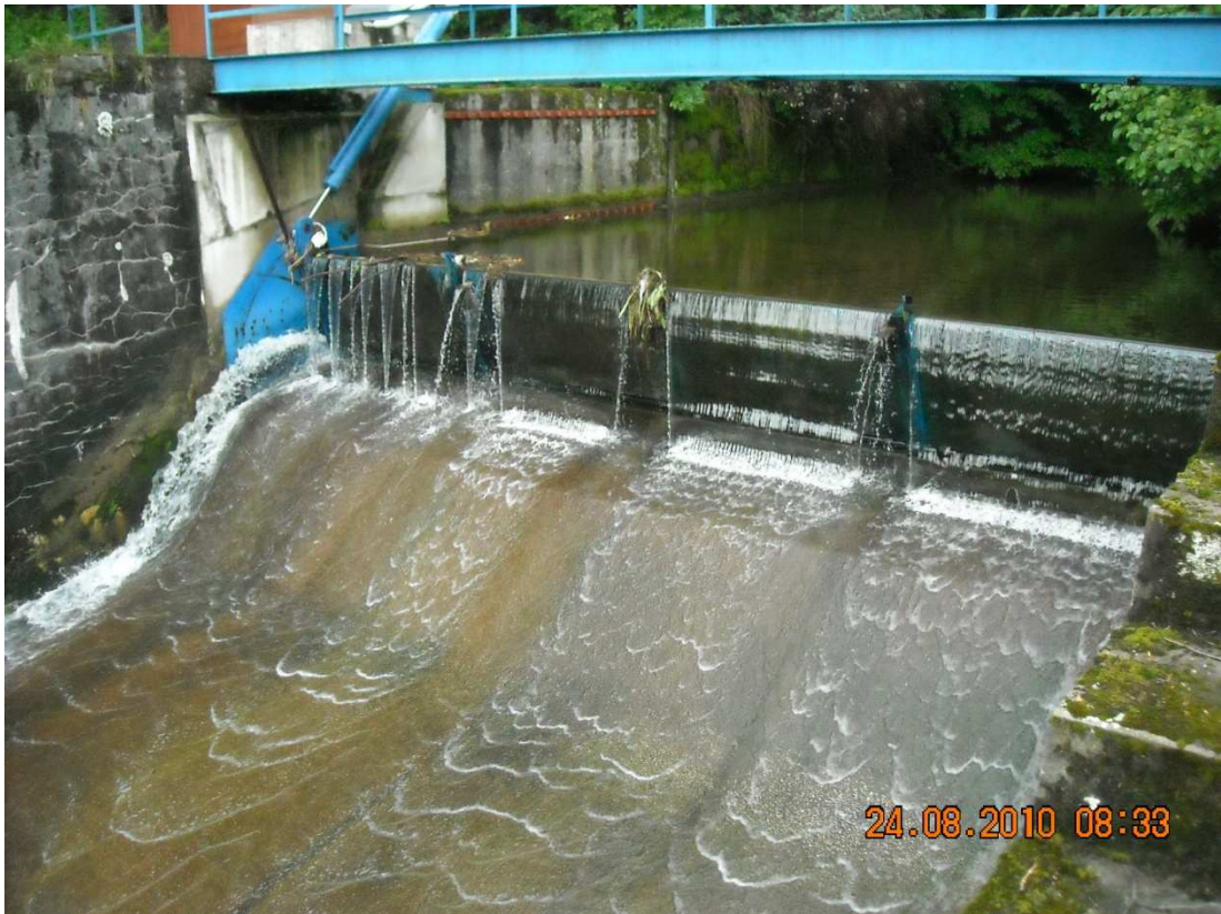
Obrázek č. 6 – Vzdouvací objekt s pohyblivou hradící konstrukcí v obci Lánov (Malé Labe). Foto: autor.
