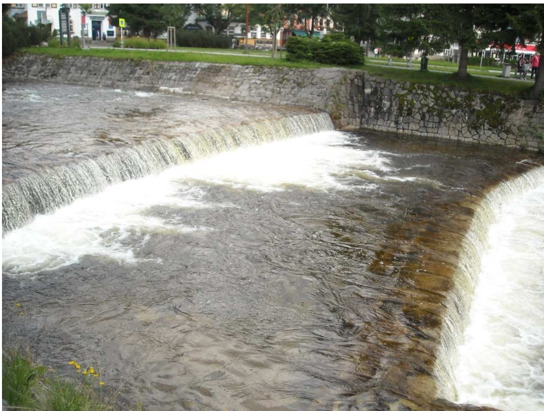
Obrázek č. 9 - Hladce opevněné koryto s prahy v intravilánu obce Špindlerův Mlýn (Labe). Foto: autor.
