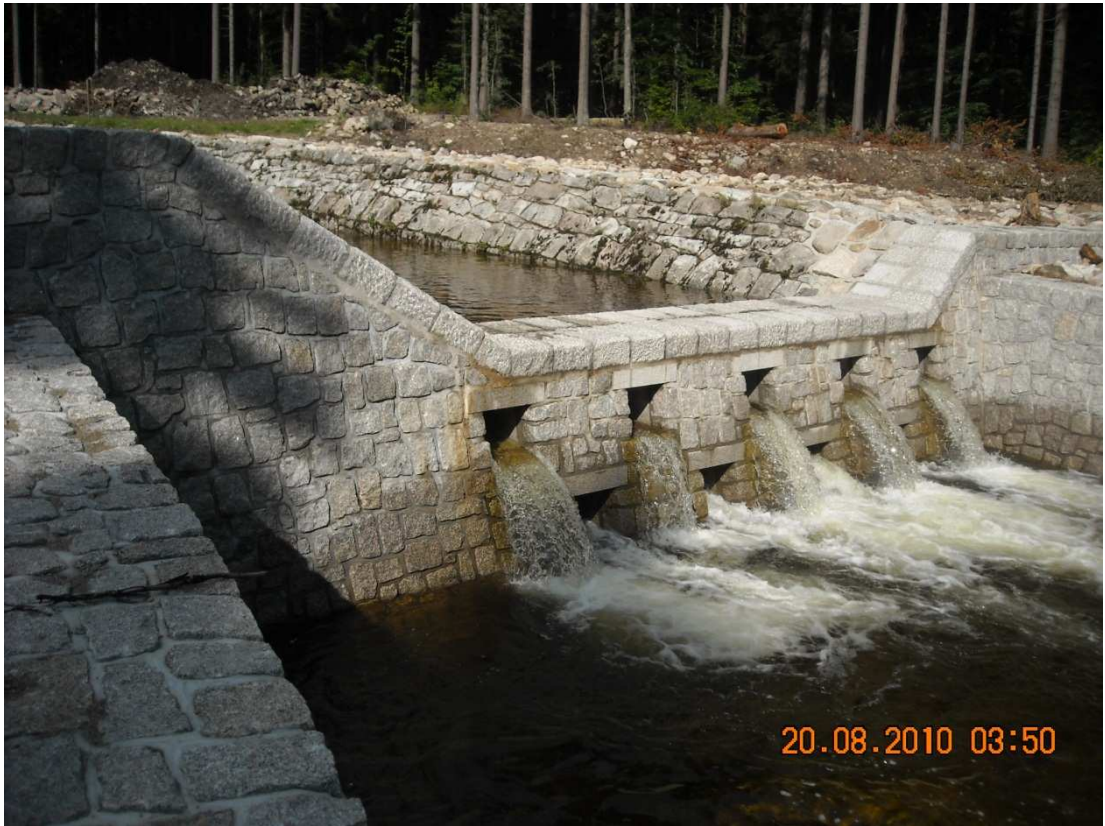
Obrázek č. 4 - Zděná přehrážka v korytě Labe (Špindlerův Mlýn). Foto: autor.
