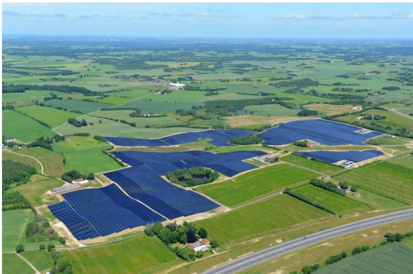
Obrázek 12 Solární výtopna, Silkeborg, Dánsko [41]
