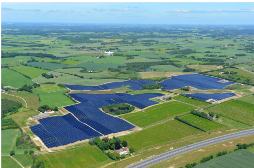
Obrázek 12 Solární výtopna, Silkeborg, Dánsko [41]
