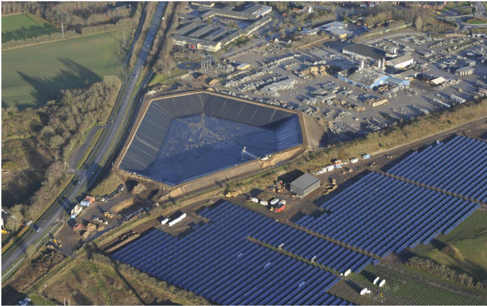
Obrázek 13 Solární výtopna, Vojens, Dánsko [43]
