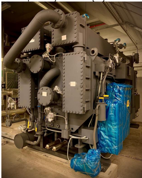
Obrázek 15 Tepelné čerpadlo SAKO, Brno [47]
