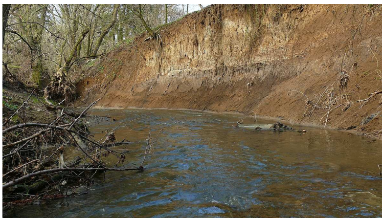
Obr. 21. dolní část úseku č. 4
