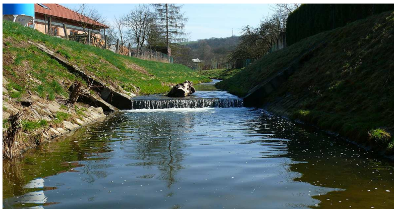
Obr. 16. hraniční splav rozdělující úsek č. 2 a 3
