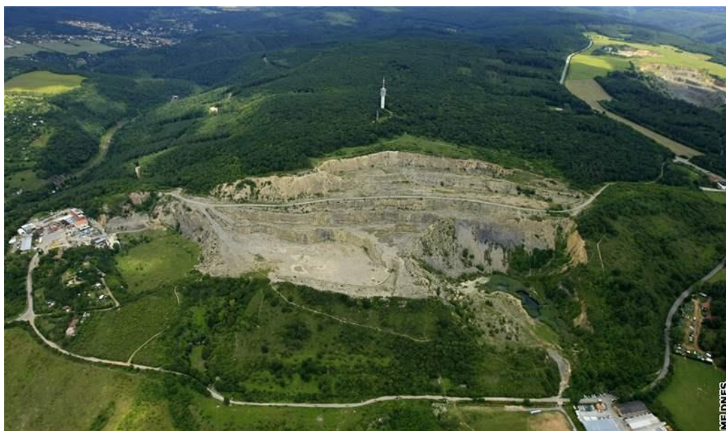
Obr. . 2: Lom Hády (zdroj: http://brno.idnes.cz )
