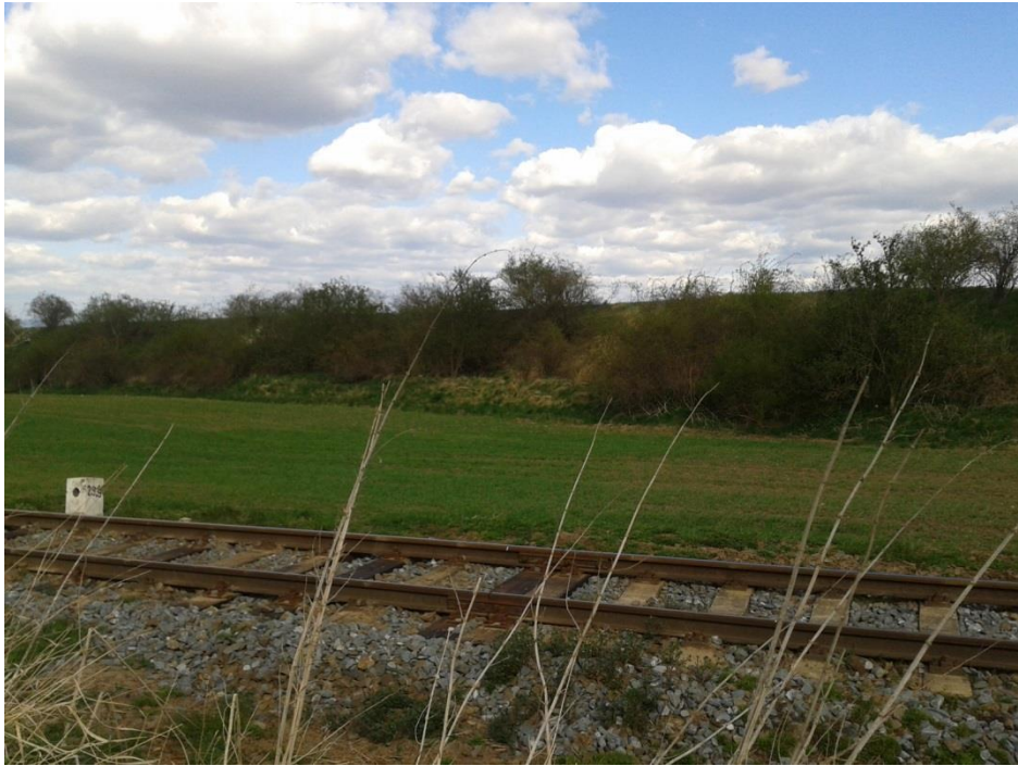
Obr. . 22: fielezni ní násep navazující na Les1 ( Foto: J. Hamalová, 12. 10. 2014)
