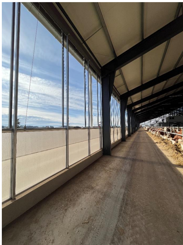
Obr. P. 2 Pohled na stahovací rolety
