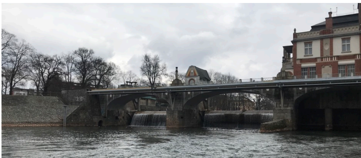
Obr. 25 Vodní elektrárna Hučák v současné době (zdroj: vlastní fotografie)
