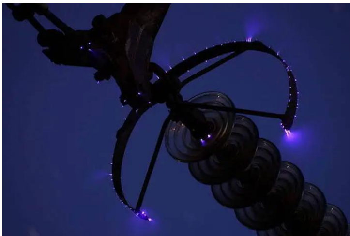
Obrázok 4 Korónový výboj na vysokonapäťovom elektrickom vedení [6]
