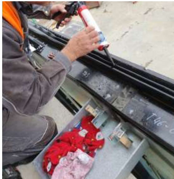
Obrázek 39-Prolepení vodorovného těsnění
