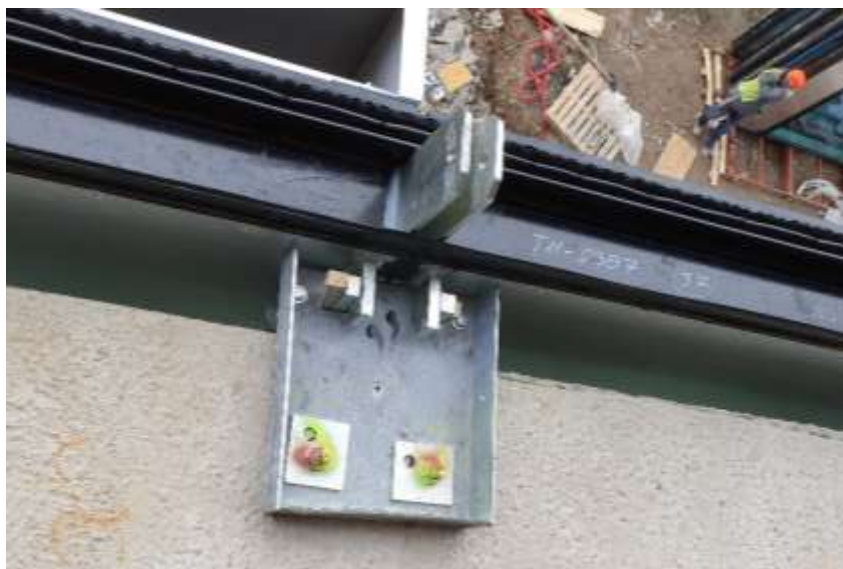
Obrázek 36-Rektifikace bloku
