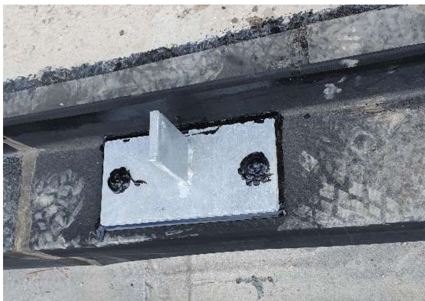
Obrázek 33-Protmelená kotva
