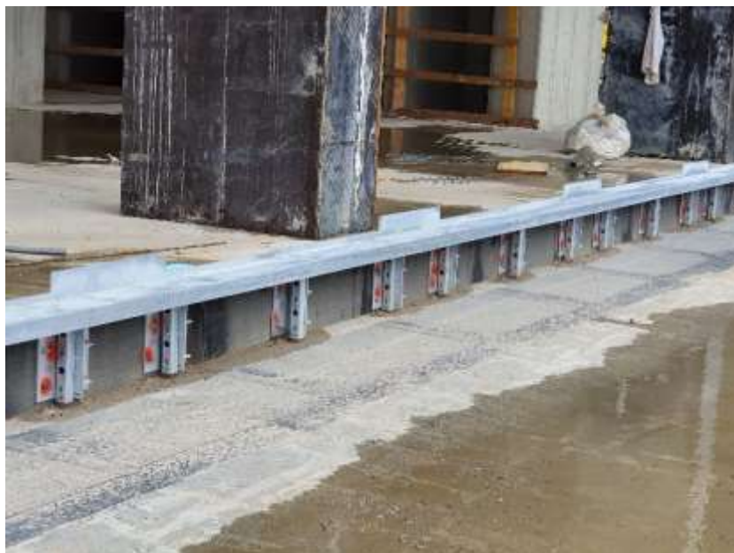
Obrázek 32-Montáž kotev
