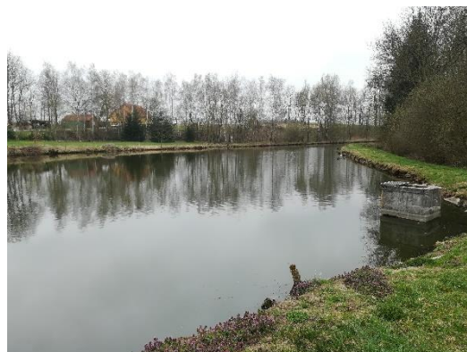
Obr. 14 Pohled na hráž obecní nádrže s výpustí – foto vlastní
