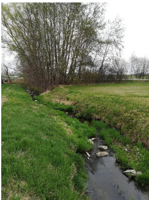
Obr. 24 Pohled na LBK 2 – foto vlastní
