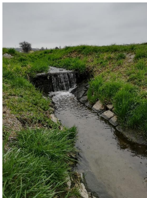
Obr. 20 Příčný objekt a kamenné opevnění břehů na Třebonínském potoce – foto vlastní
