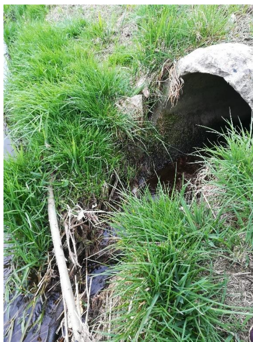
Obr. 30 Vyústění odvodnění do Třebonínského potoku za obcí – foto vlastní
