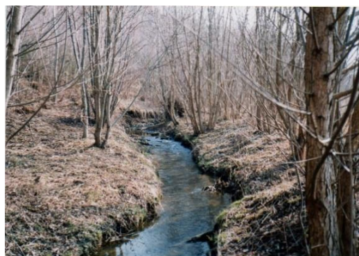
Obr. 9 Čekanovský potok – opevněný úsek doprovázený náletem dřevin – foto vlastní
